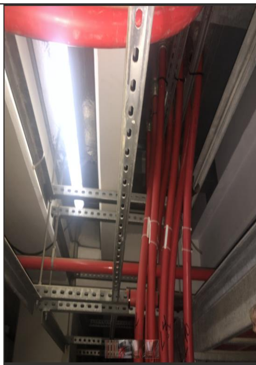
Cables de media tensión a ingreso celda A15.
