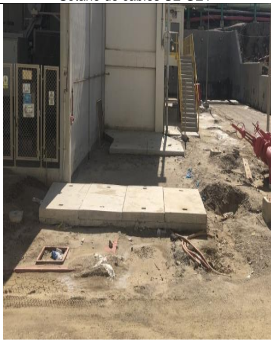
Buzón 1 con 04 tapas de concreto 1.5 Tm.
