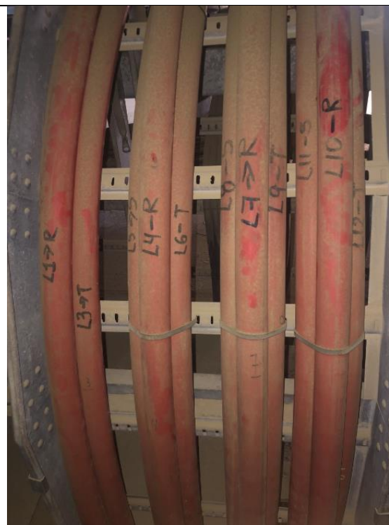
Ingreso de cables de media tensión 33 kV a sótano de cables SEP
