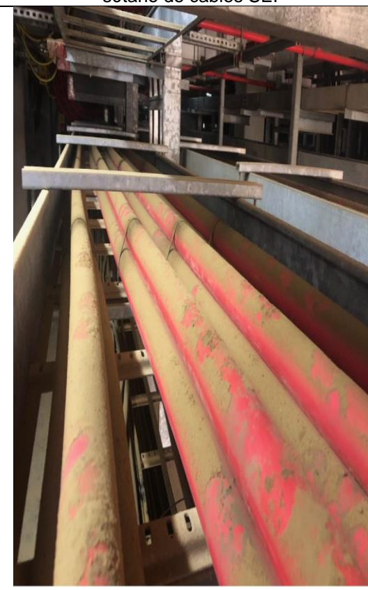
Recorrido de cables de media tensión 33 kV por bandejas.
