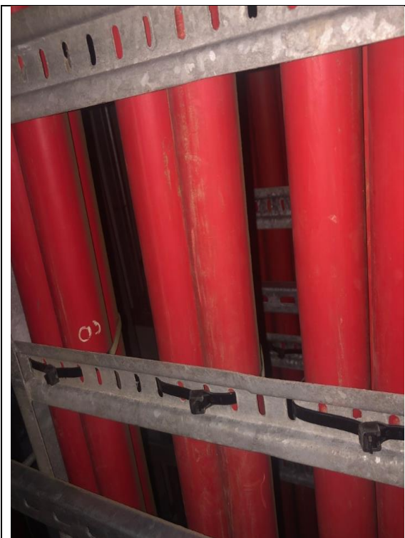
Cables de media tensión con amarracables por bandejas.
