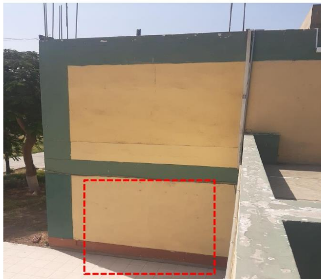
IMAGEN N° 03: Se observa el área de demolición y/o corte en parapetos para generar acceso al elevador para personas con discapacidad.
