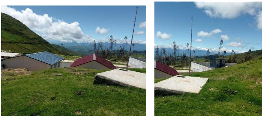
Fotografía N°06: Pozo de agua existente el cual es de revestimiento de cemento, en buen estado de conservación.
