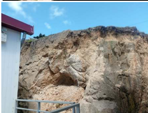
Fotografía N°09: Se nota en las vistas el nivel predominante, por lo cual se recomienda la construcción de muro de contención de acuerdo al emplazamiento requerido.
