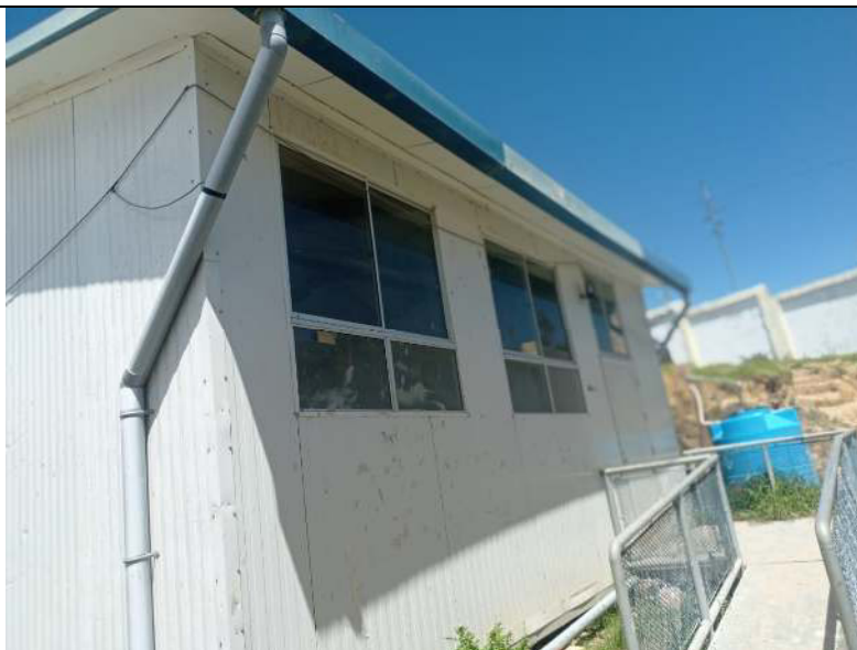
Fotografía N° 03: Módulos de aula prefabricados, de acuerdo al diagnóstico en estado bueno de conservación.
