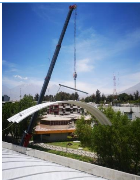
Fotografía referencial: proceso de izaje de tercetas de arcos parabólicos
