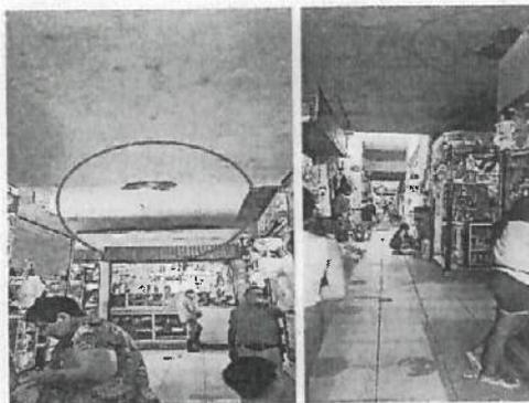
Área de circulación en la que se puede observar que en la parte del techo está filtrando, afectándose más debido al periodo lluvioso, ocasionando un desprendimiento de material.
