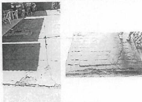
Vereda, rampa, con presencia de fallas como son fisuras, grietas ocasionando un desprendimiento de material.
