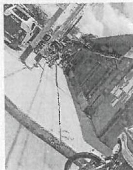
Cerco perimétrico, con estructuras metálicas con presencia de patologías de oxidación y corrosión.
