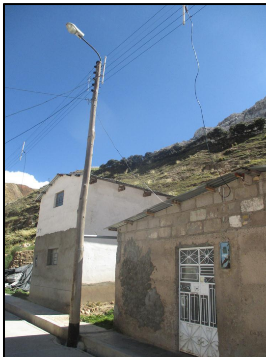
Fig. N° 09: Postes en mal estado Cantagallo
