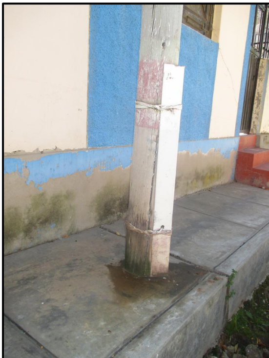
Fig. N° 07: Postes en mal estado Tallapuquio
