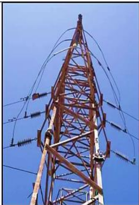
Disposición de aisladores de anclaje
