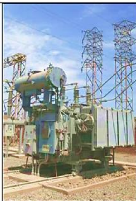
Transformador 60/10 kV, 7 MVA
