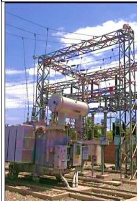
Transformador 60/22,9/10 kV, 5 MVA
