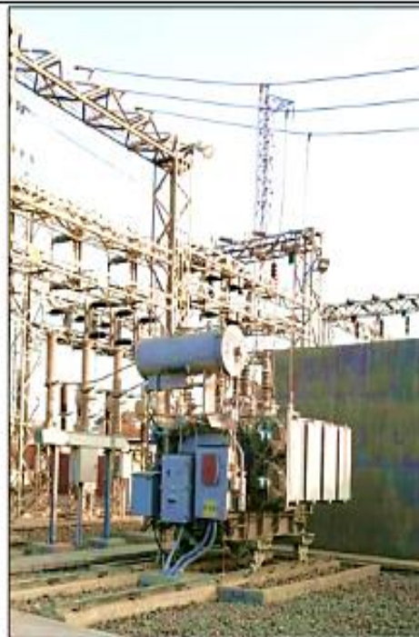
Transformador 60/10 kV, 5 MVA
