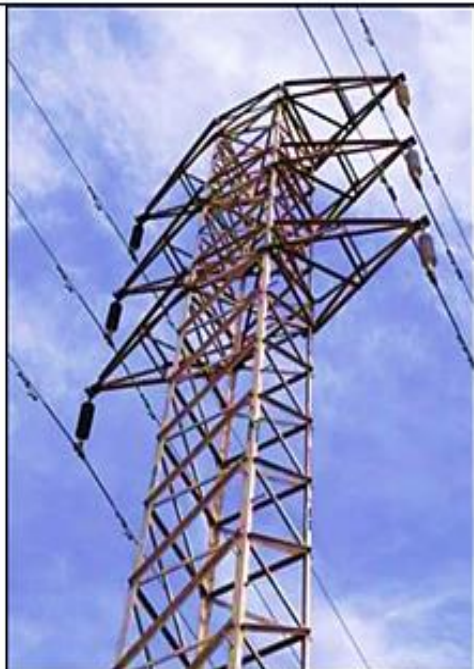
Estructura con aisladores poliméricos
