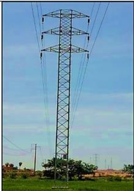
Estructura de suspensión doble terna
