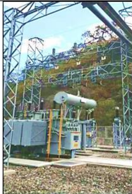
Transformador 60/22,9/10 kV, 7 MVA
