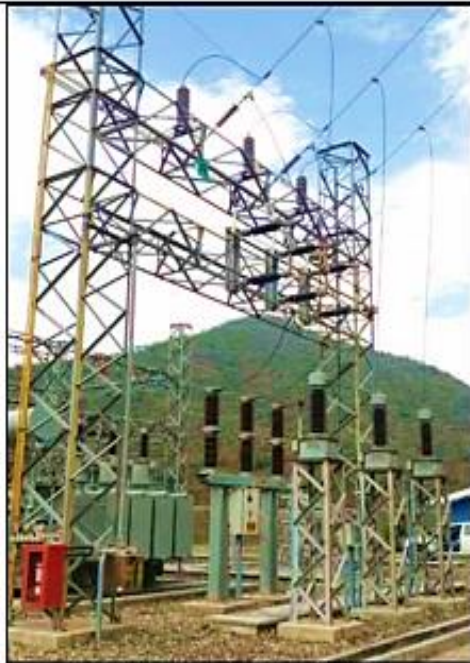
Equipamiento de celda 60 kV
