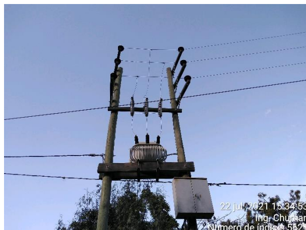
SED de 50 kVA en la localidad de Lampa.
