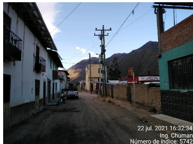
Disposición horizontal de conductores en redes primarias en Marcabamba
