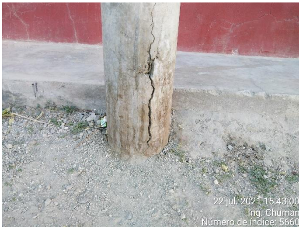
Base de postes de concreto de 8m fisurados en Lampa
