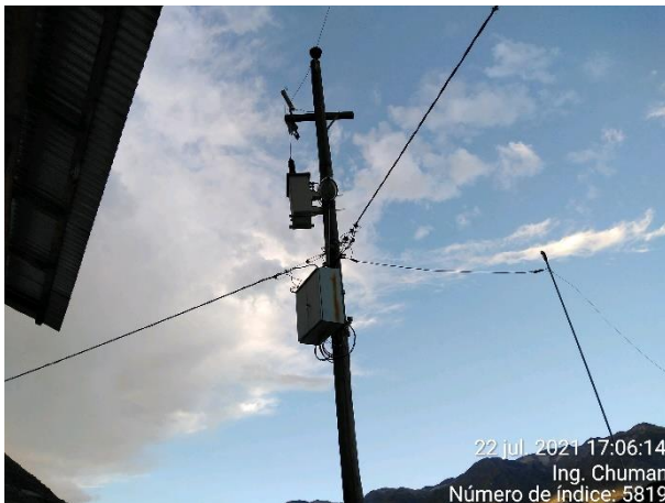
SED de 10 kVA en Nahualta en mal estado de conservación.
