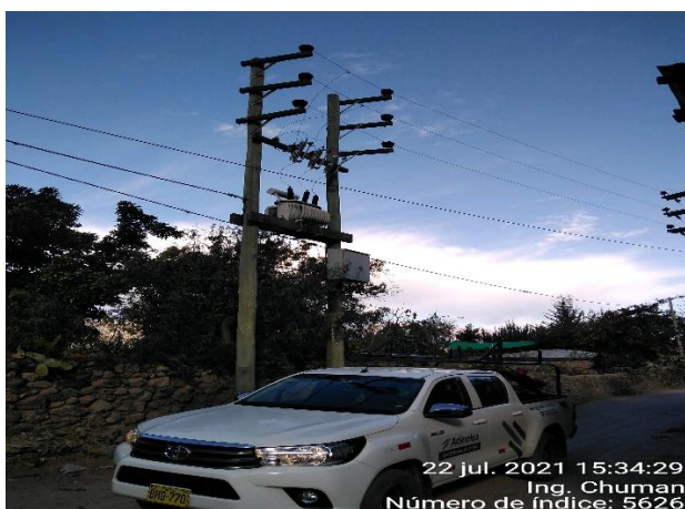
Subestación en Lampa en regular estado de conservación, presente deterioro en la base.
