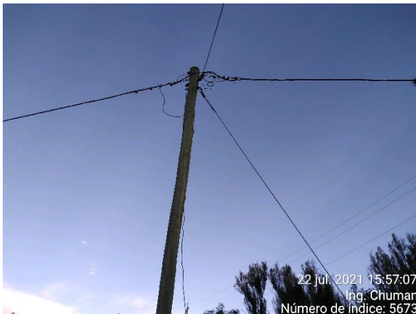
Conductor Autoportante en mal estado de conservación en localidad de Colcabamba
