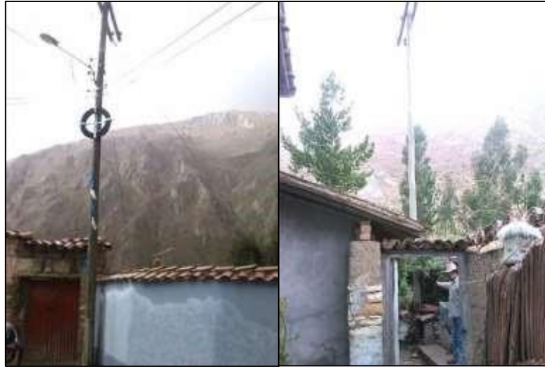
Fig. 3. Postes de madera de media tensión deteriorados
