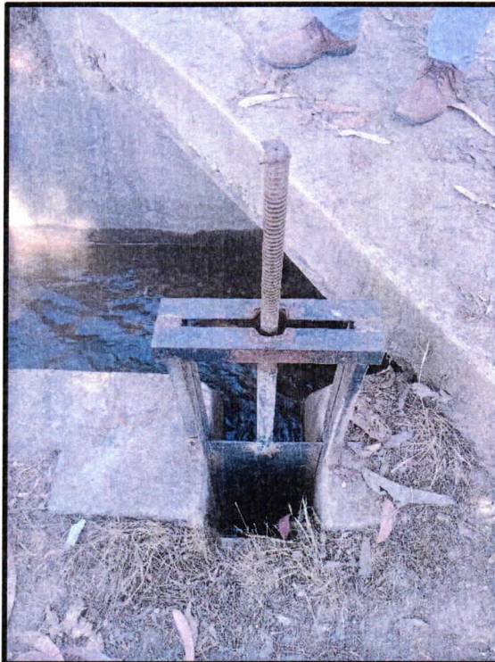
FOTOGRAFIA N° 06: COMPUERTA DE CANAL SIN VOLANTE
