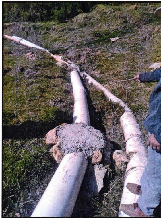
FOTOGRAFIA N° 03: TUBERÍA PARA CANAL EN MAL ESTADO
