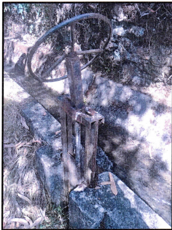
FOTOGRAFIA N° 02: COMPUERTA EN MAL ESTADO
