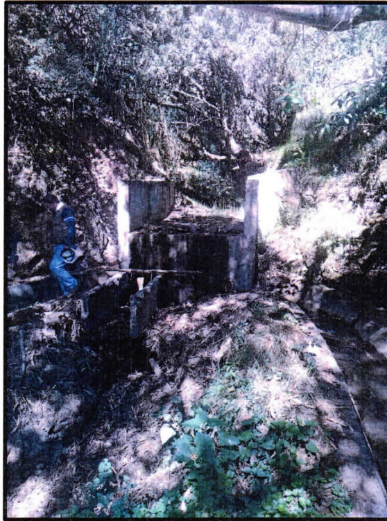
FOTOGRAFIA N° 05: MURO DE CANAL DETERIORADO
