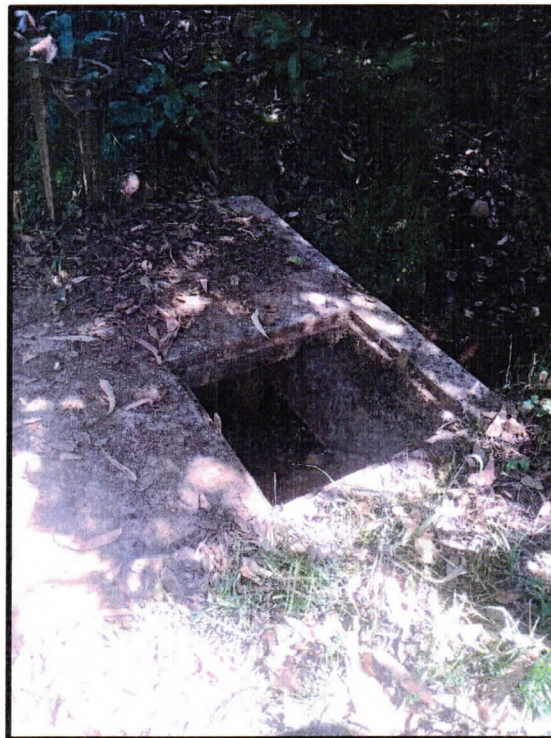
FOTOGRAFIA N° 04: CAJA DE CONTROL DE CANAL SIN TAPA METÁLICA
