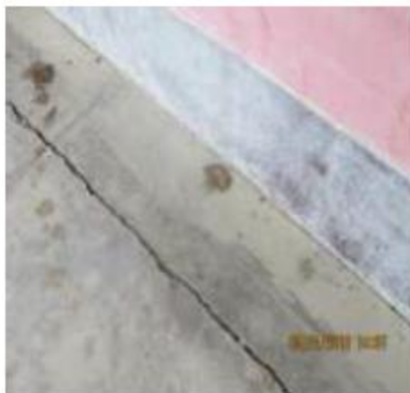
Fotos N° 52, 53 : En vistas se observa parte posterior y lateral del pabellón 4.No cuenta con veredas, lo que la cimentación queda al descubierto.
