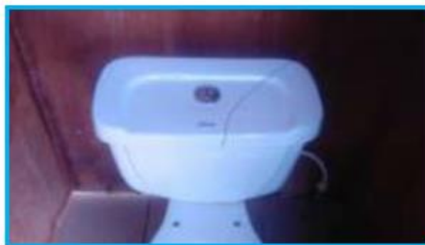
Fotos N°20 , 21,22 : En vistas se aprecia parte frontal y posterior de los SS.HH en malas condiciones. Tapa del inodoro rajada.
