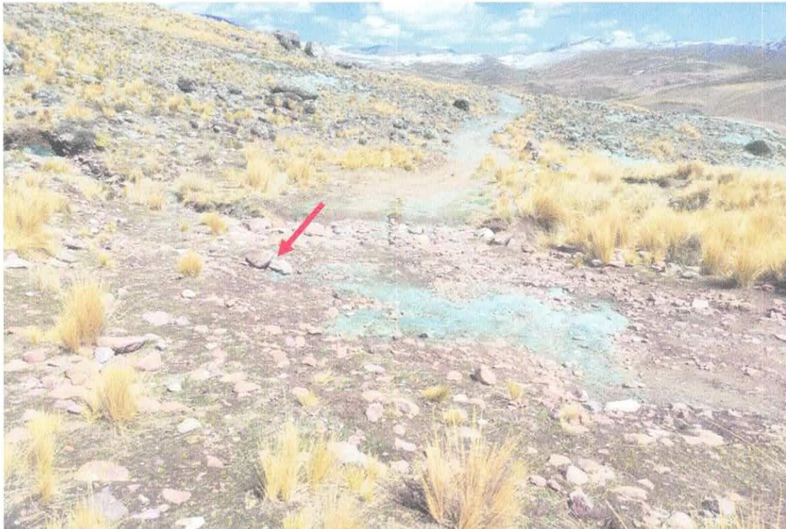
Foto N° 02.- Caída material aluvial que acumula en la plataforma de rodadura. Que son intransitables en temporadas lluviosas
