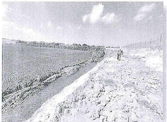
FOTOGRAFIA N° 06: La imagen muestra la afectación de bordo en su margen izquierdo del canal Teniente, producto del escurrimiento de agua extraordinario en los sectores de riego y activación de quebradas aguas arriba. Así también muestra la necesidad de restablecer el acceso por el camino de vigilancia.
