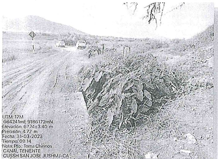
FOTOGRAFIA N° 05: La imagen muestra el Canal Teniente Colmatado y con presencia de sedimentos en su cauce.
