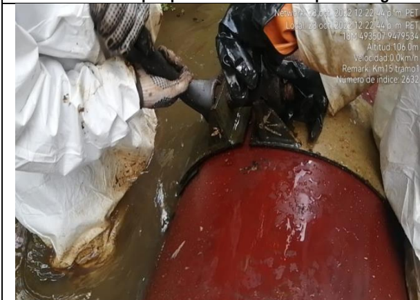
Instalación de grapa emperrada de 15 cm
