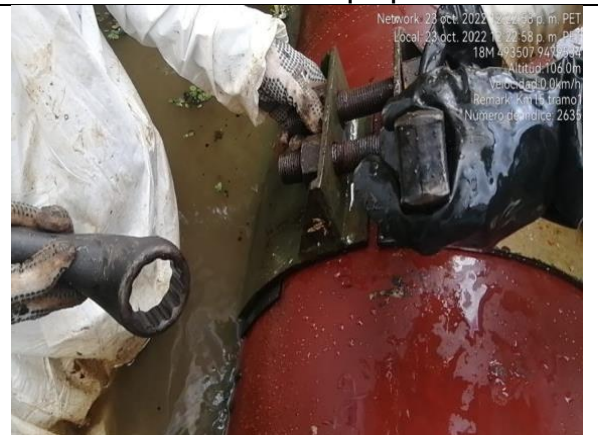
Instalación de grapa emperrada de 15 cm
