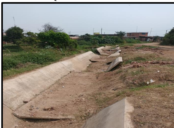
FOTO N°05.- SE MUESTRA QUE EN LA PROGRESIVA KM 0+229.60 -KM 0+280.00 SE MUESTRA QUE LOS PAÑOS DETERIORADOS
