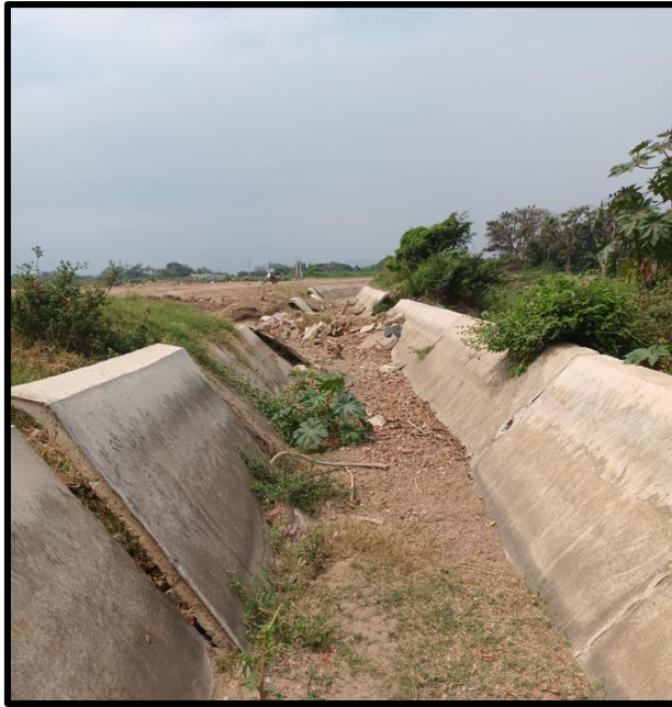
FOTO N°06.- SE MUESTRA QUE EN LA PROGRESIVA KM 0+229.60 -KM 0+280.00 SE MUESTRA QUE LOS PAÑOS DETERIORADOS
