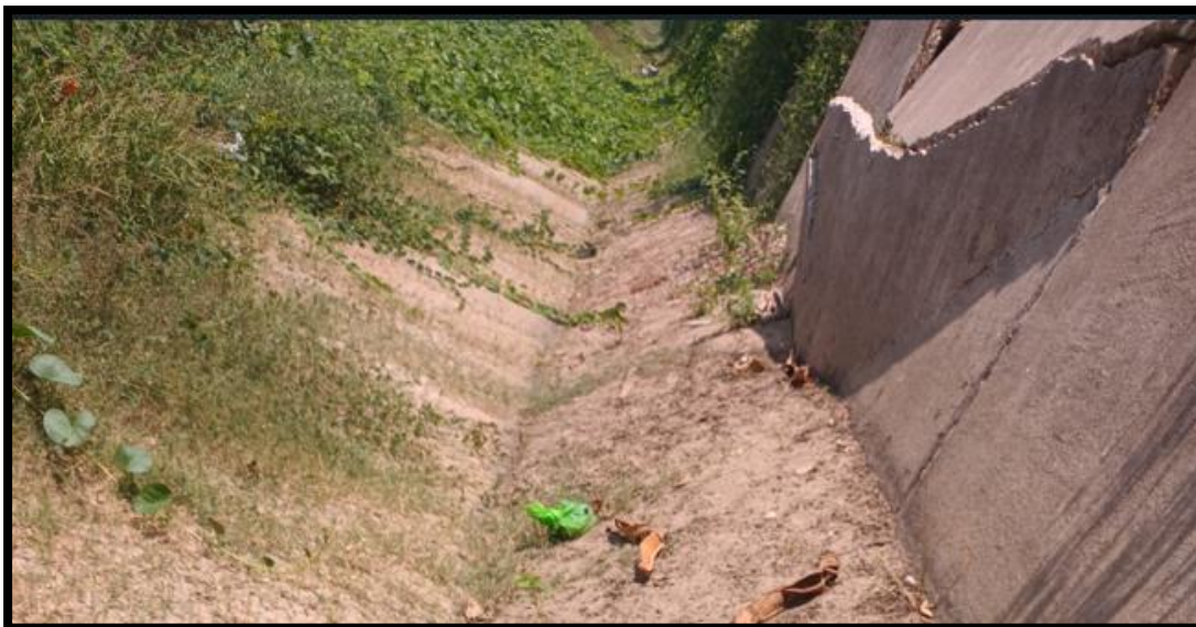
FOTO N°03.- SE MUESTRA QUE LOS PAÑOS DEL CANAL ESTAN COLAPSADO EN LA PROGRESIVA KM 0+291.30 – KM 0+294.30
