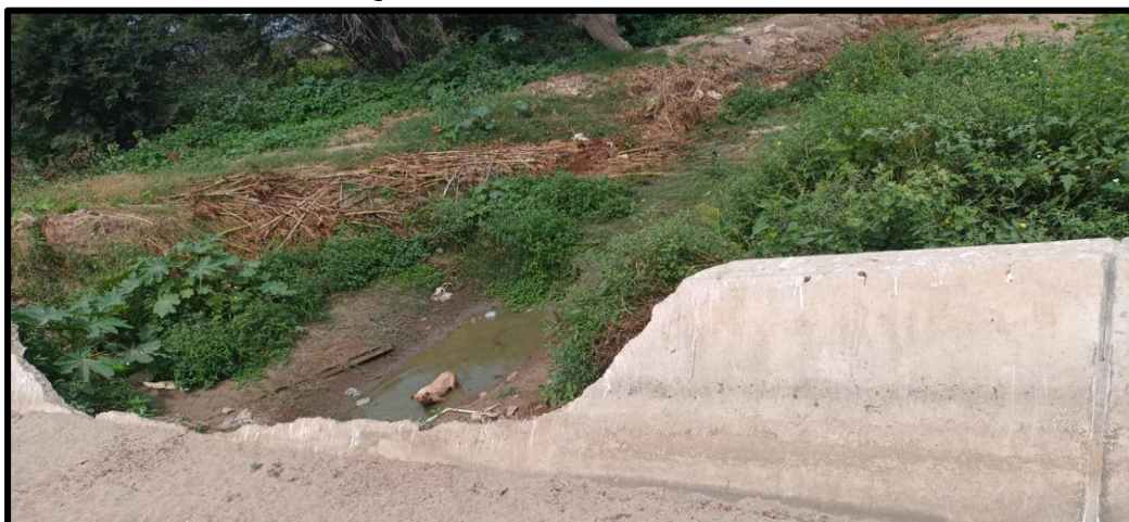
FOTO N°04 .- SE MUESTRA QUE EN LA PROGRESIVA KM 0+186.00 -KM 0+198.30 SE MUESTRA QUE LOS PAÑOS DETERIORADOS
