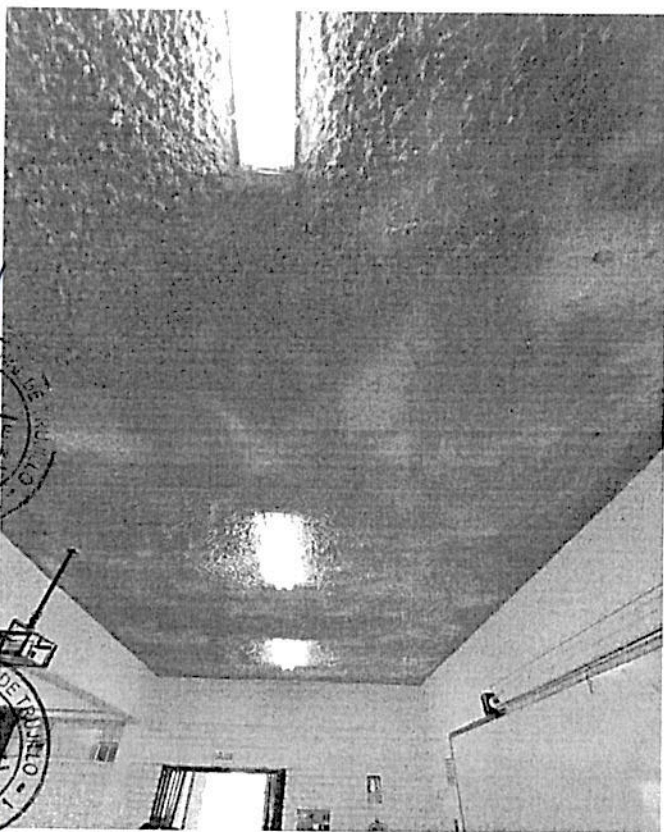
Cielorrasos, antiguos, (material asbesto),
