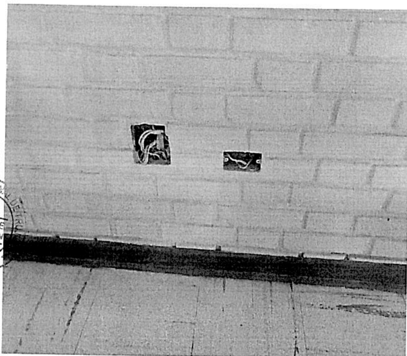
Accesorios eléctricos, rotos, (tomacorrientes)
