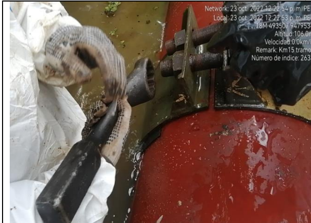
Retiro de la grapa metálica instalada para la constatación
