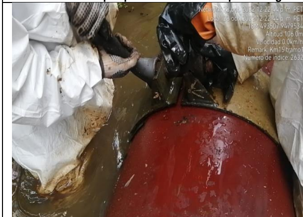
Instalación de grapa emperrada de 15 cm de longitud
