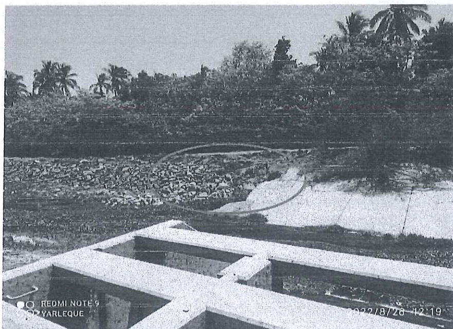
Foto N°06: Zona de reposición con roca y protección con concreto simple F'c=210 Kg/cm2.
