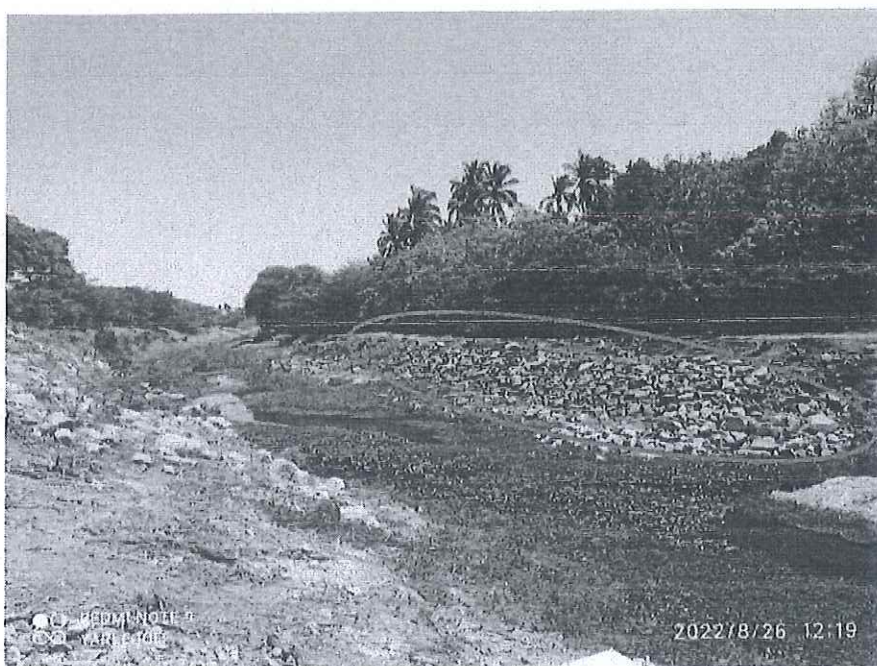
Foto N°04: Talud derecho del Dren ND01 en mal estado.
