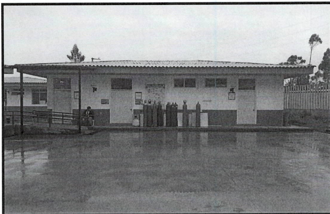
FOTO N° 11: En la imagen se puede apreciar la falta de canaletas de drenaje pluvial.
