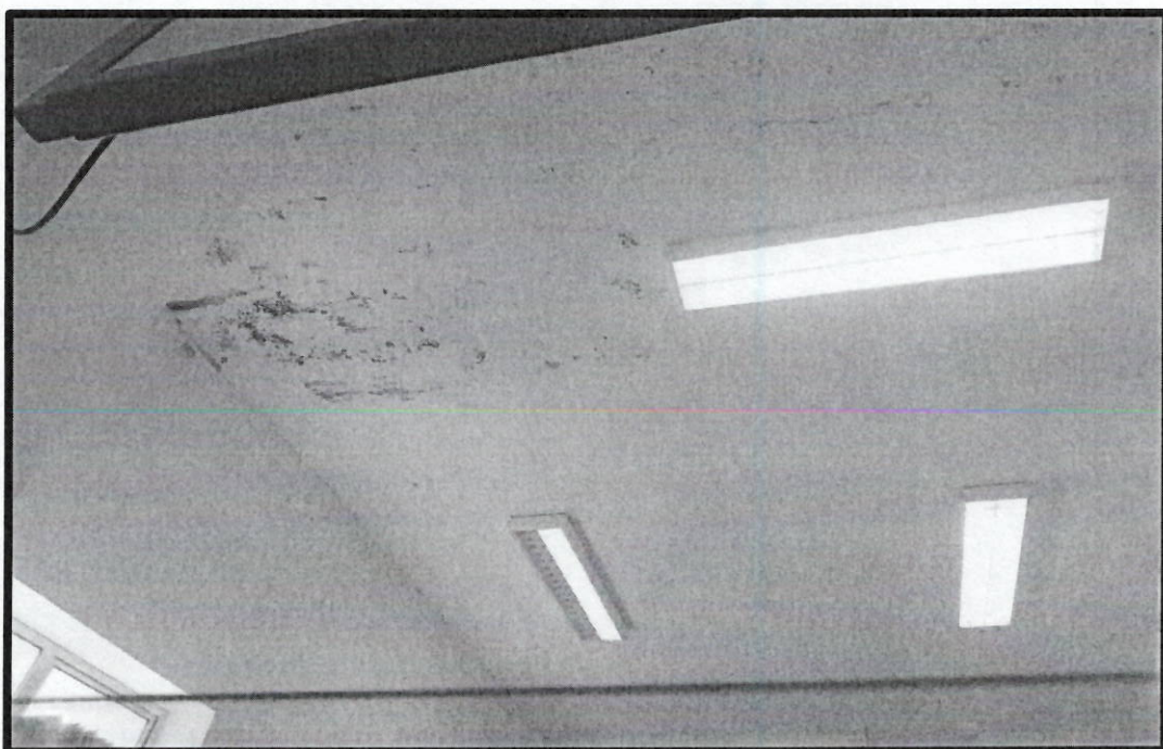
FOTO N° 08: en la imagen se aprecia filtraciones en el cielorraso del pabellón de administración.
