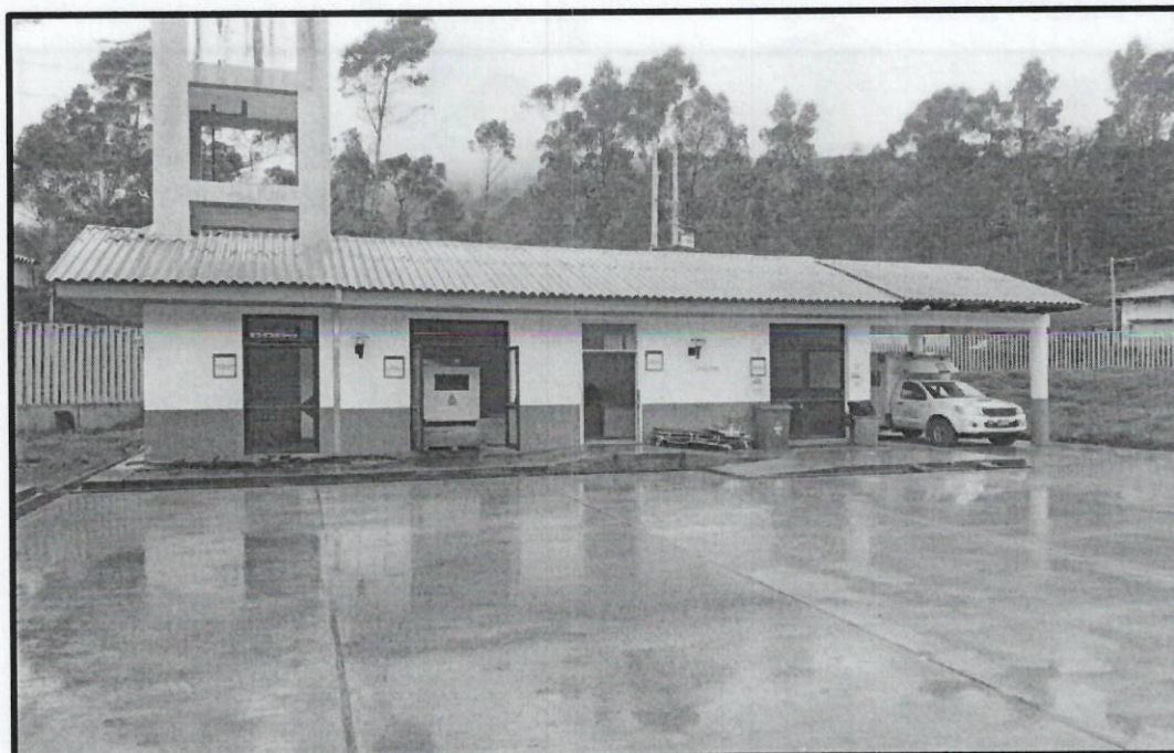
FOTO N° 04: En la imagen se puede apreciar que se necesita la instalación de canaletas en el pabellón de instalaciones eléctricas.
