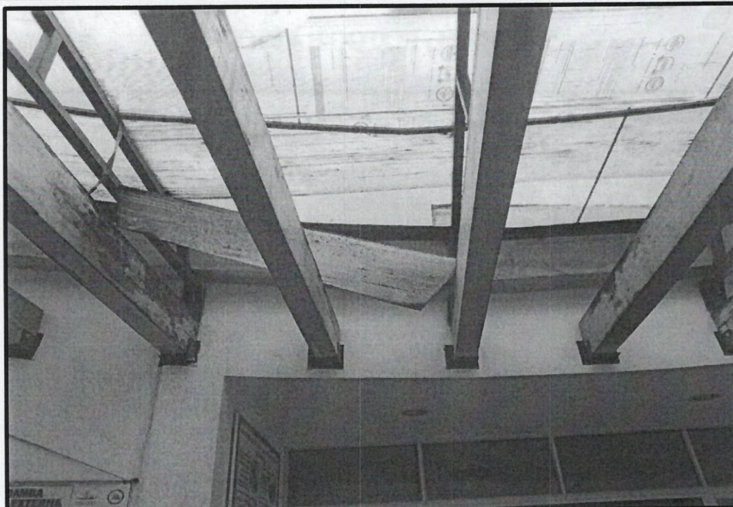
FOTO N° 03: En la imagen se aprecia que el techo de policarbonato está deteriorado.
