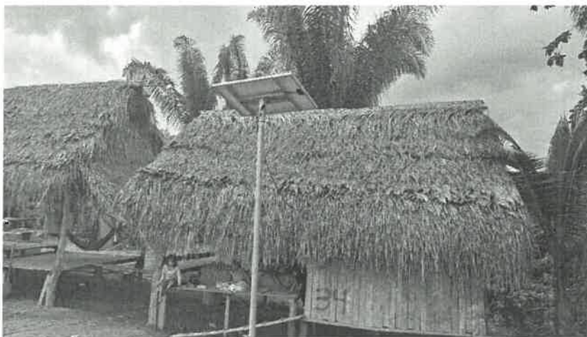
Sistema de luz eléctrica mediante paneles solares
