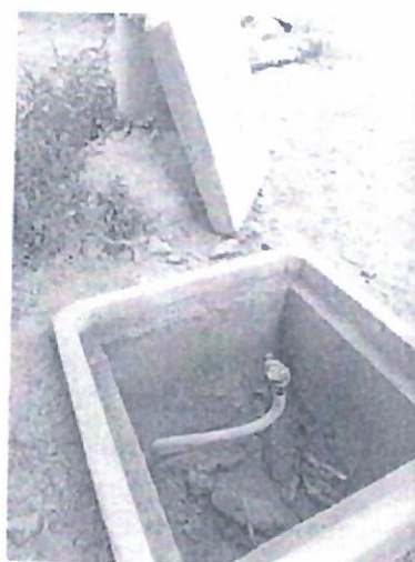
Puesta a tierra requiere mantenimiento
