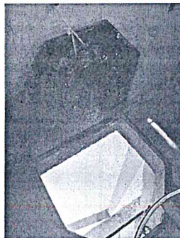
Vista de las Tapas Metálicas: desgaste de pintura y bisagras, presencia de óxido, descuadre de tapa, pita que sostiene a la tapa al momento de la apertura, tapa sin refuerzo en la parte inferior.
