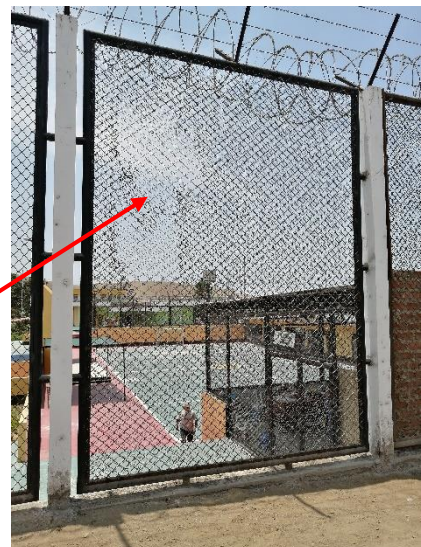
Vista de la malla metálica y su marco en mal estado,
