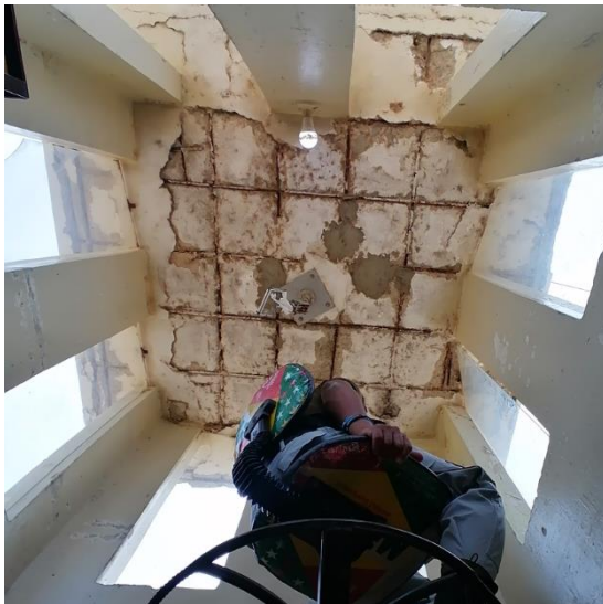
Vista del Interior y Exterior del Techo del Torreón n°8 en mal estado.
