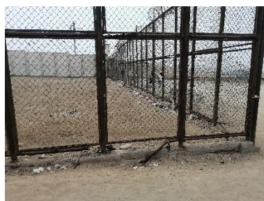
Vista de los sobrecimientos del cerco metálico en mal estado.
