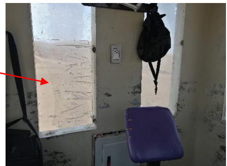
Vidrios con Presencia de rajaduras
