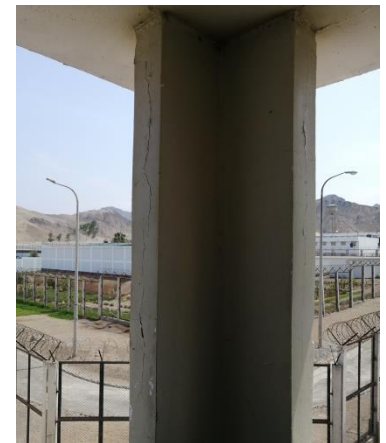
Vista de los vanos de las ventanas en torreones, recubrimiento de concreto desprendido y fisuras a reparar.
