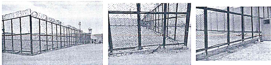
Vista de los sobrecimientos del cerco metálico en mal estado.
