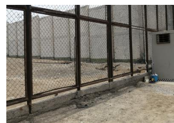
Vista de los sobrecimientos del cerco metálico en mal estado.
