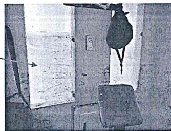
Vidrios con Presencia de rajaduras
