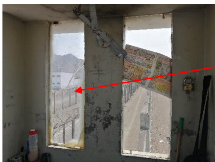
Vidrios con Presencia de rajaduras
