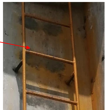
Escalera metálica a desmontar Estructura corroída
