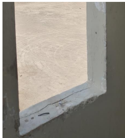
Vista de los vanos de las ventanas en torreones, recubrimiento de concreto desprendido y fisuras a reparar.
