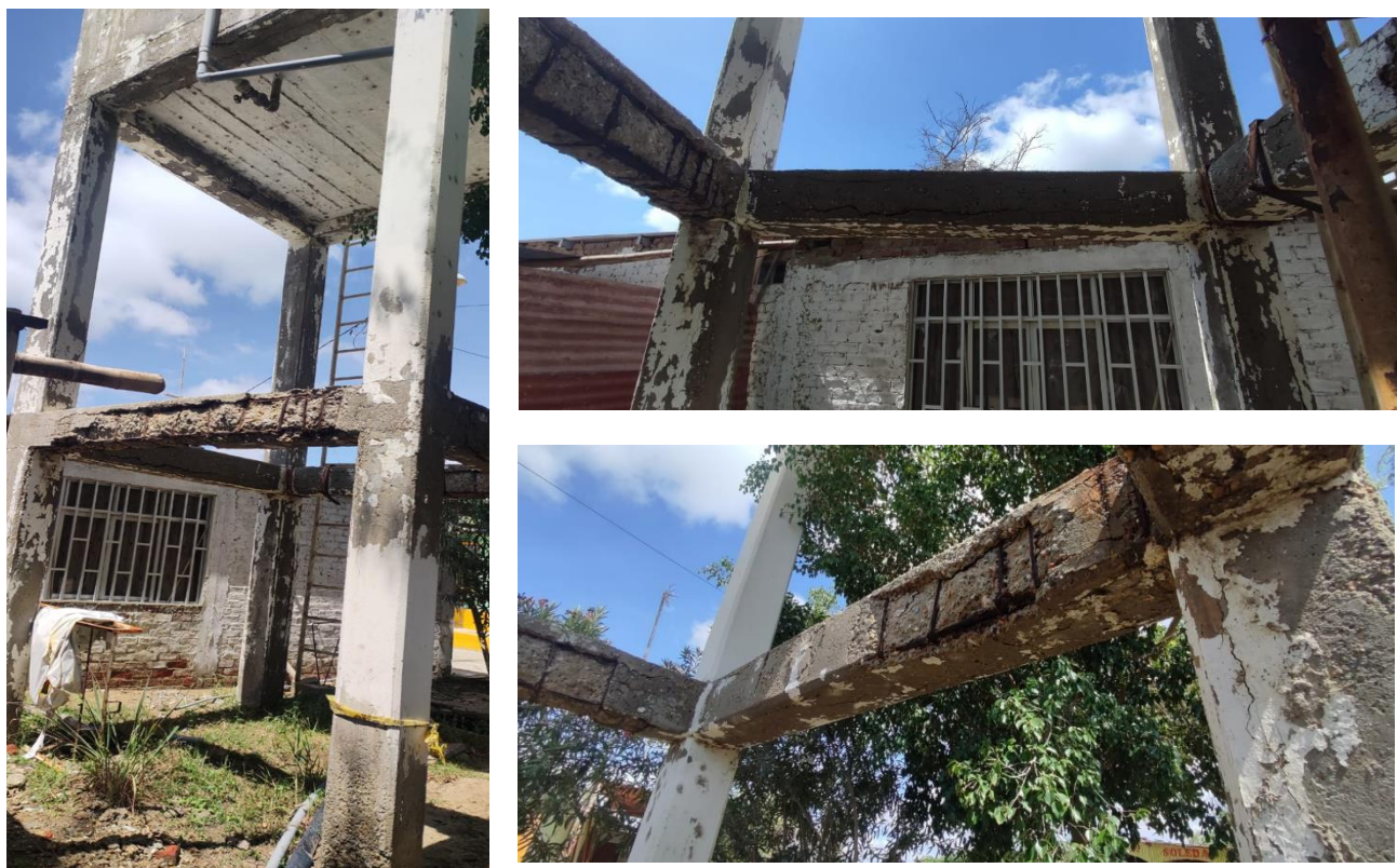
IMAGEN 01 – Estructura de concreto del tanque elevado en mal estado.
