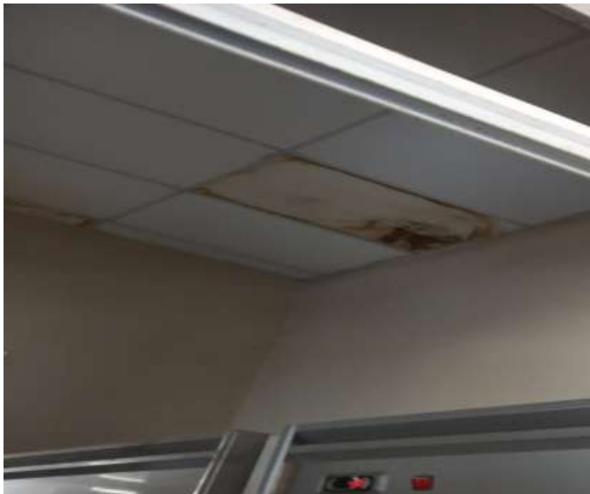
Foto 6.- Cielo raso en mal estado a reemplazar, dependiendo de su estado se contemplara el reemplazo de elementos de sujeción
