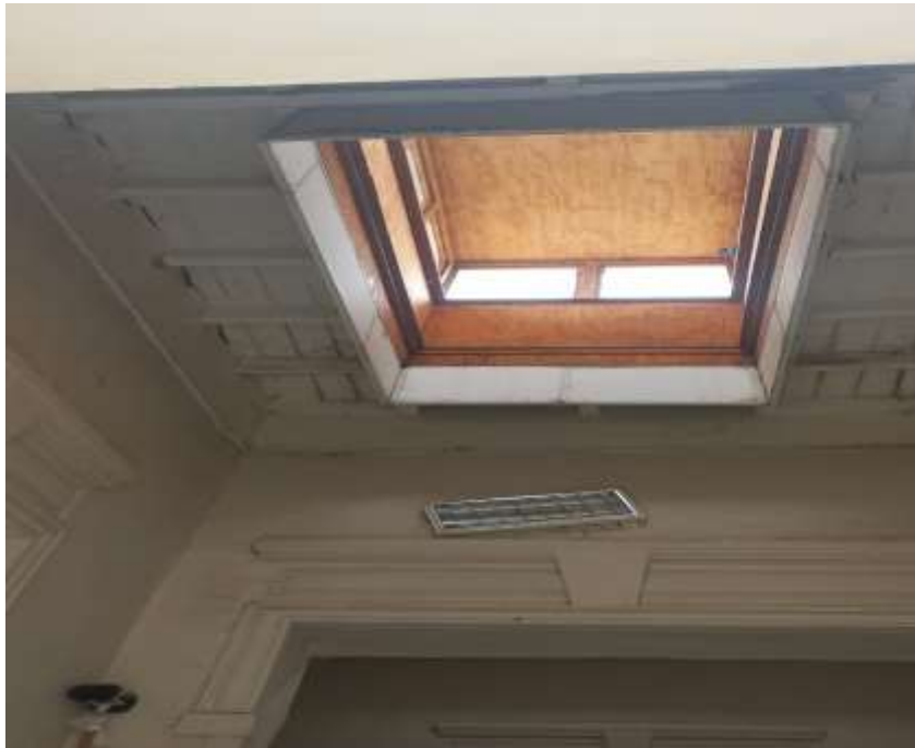
Foto 5.- Cielo raso inexistente en el pasadizo del pabellón principal del servicio de nutrición
