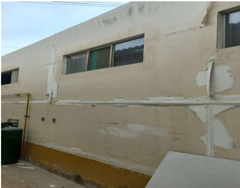
Foto 4.- Muros de drywall en mal estado, ausencia de cobertura
