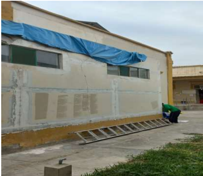
Foto 3.- Vista del almacén del servicio de nutrición, cubierta temporal con plástico debido a filtraciones de lluvia
