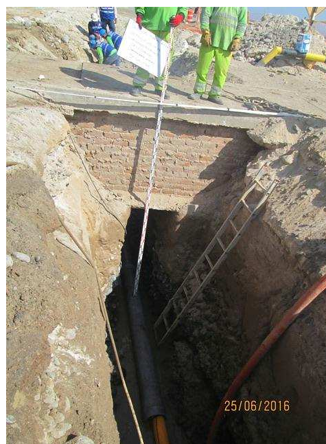
FOTO 07: REGISTRO DE TUBERÍA DE GAS - CONTUGAS_ UBICACIÓN DE TUBERÍA DE GAS CON RELACIÓN AL MURO DE CONTENCIÓN EXISTENTE
