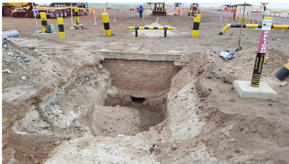
FOTO 05: MURO DE ALBAÑILERÍA QUE FORMA PARTE DEL SISTEMA DE CONTENCIÓN ACTUAL
