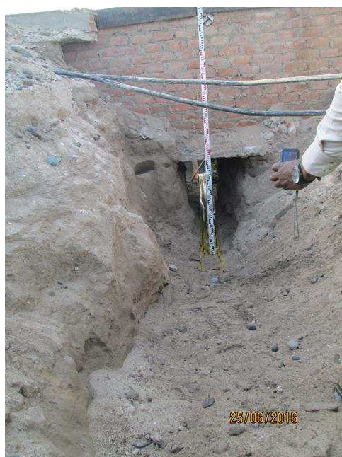
FOTO 06: REGISTRO DE UBICACIÓN DE LA CINTA DE SEGURIDAD DE LA TUBERÍA DE GAS - CONTUGAS
