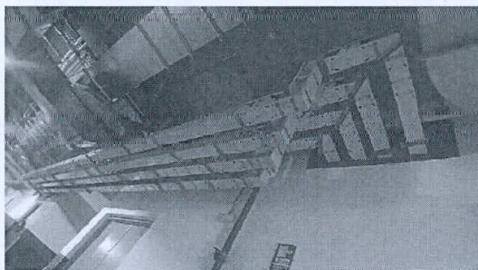
Ductos Barra y Tableros Eléctricos con Interruptor General.
