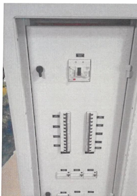
(3) Gabinete sub tablero tipo empotrado (foto referencial)
