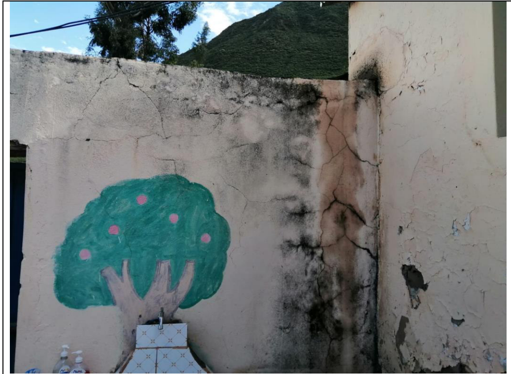
Foto N°05: Vista del cerco perimétrico material de adobe en mal estado
