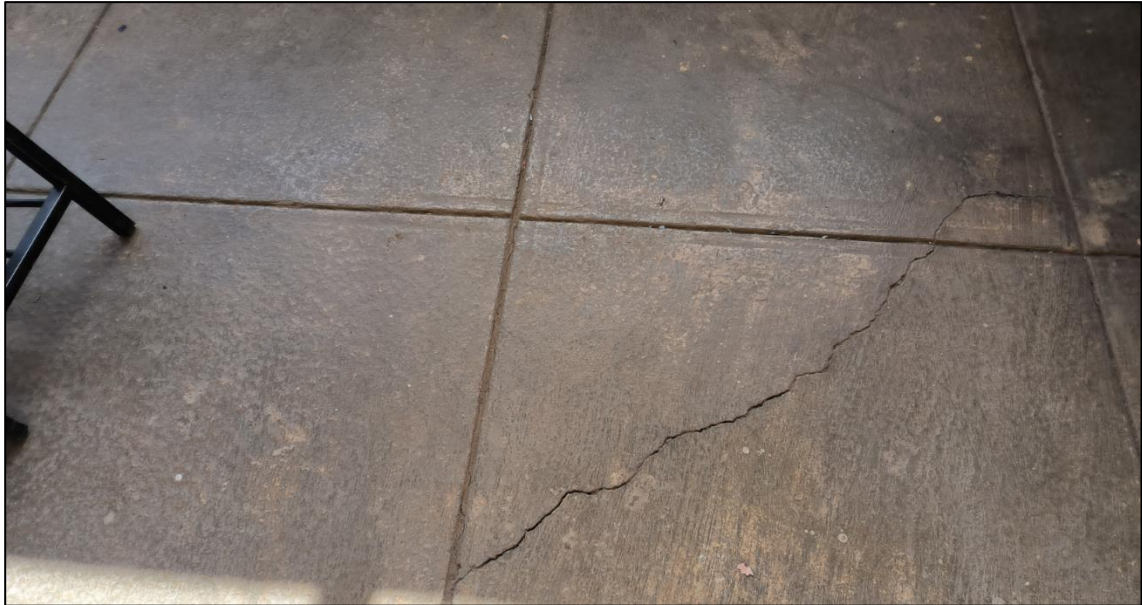
Imagen 07: Se observa el piso con presencia de grietas producto del asentamiento del suelo y cimientos.
