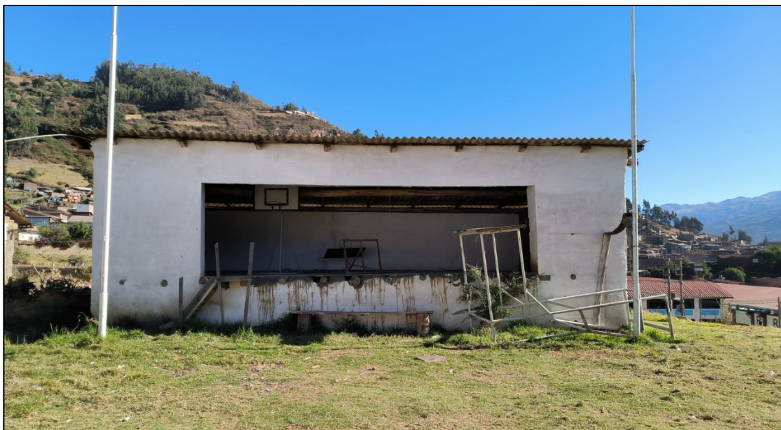
Imagen 04: Se aprecia estructura de adobe precaria en proceso de derrumbe por la antigüedad, este módulo fue adecuado para uso de escenario.
