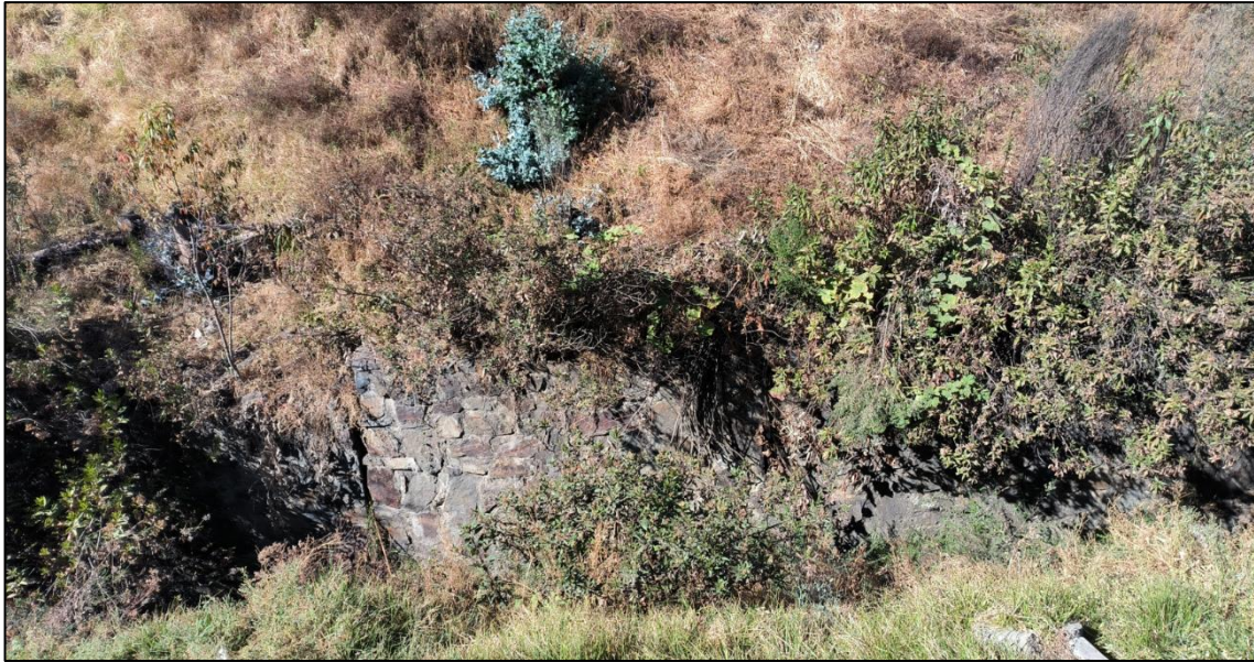
Imagen 03: Se aprecia que el muro de protección de material concreto ciclópeo, se encuentra desgastado e inclinado por la fuerza de empuje del talud.
