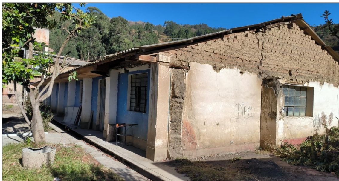
Imagen 05: Se observa que los ambientes usados por los alumnos son de adobe, en peligro de derrumbe, sin sistema antisísmico y antiguos del año 1985.
