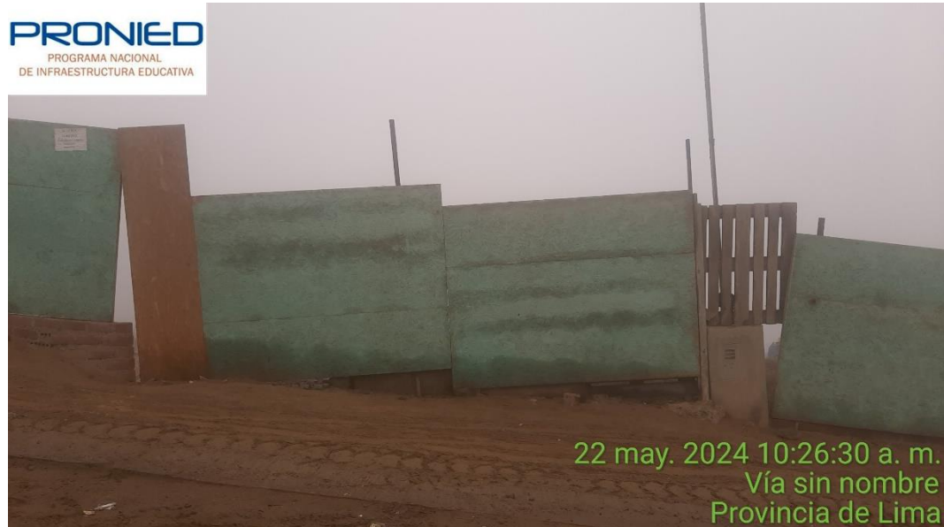
Imagen N°08: Cerco Perimétrico Vista Exterior: Cerco precario. Alrededor del medidor se levantarán columnas de confinamiento y muro de albañilería.
