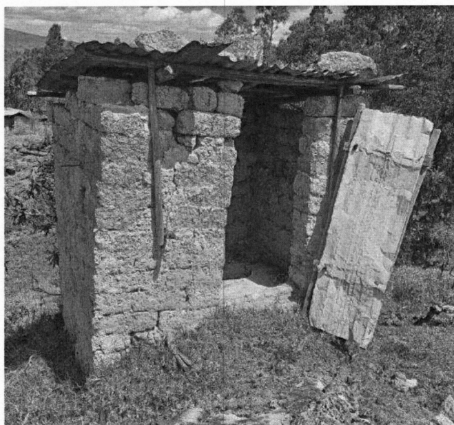
Imagen N° 28 Letrina de hoyo seco ventilado en mal estado
