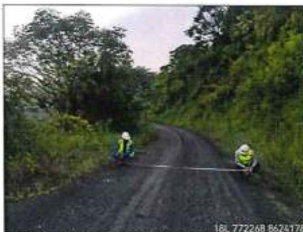
Foto 9: ANCHO DE PLATAFORMA 3.90m - km.71+860.
