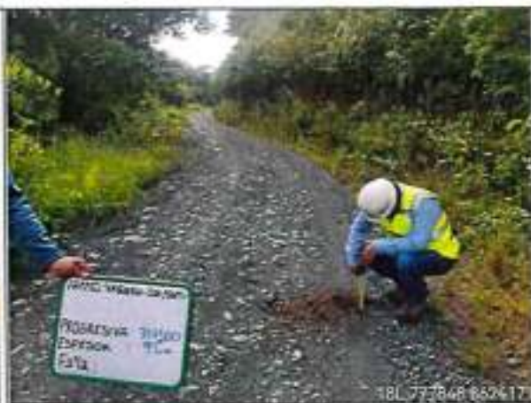
Foto 50: ESPESOR DE AFIRMADO EXISTENTE 9cm – km.81+810
