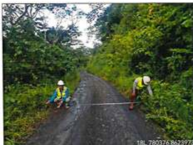
Foto 63: ANCHO DE PLATAFORMA 3.50m - km.85+300.
