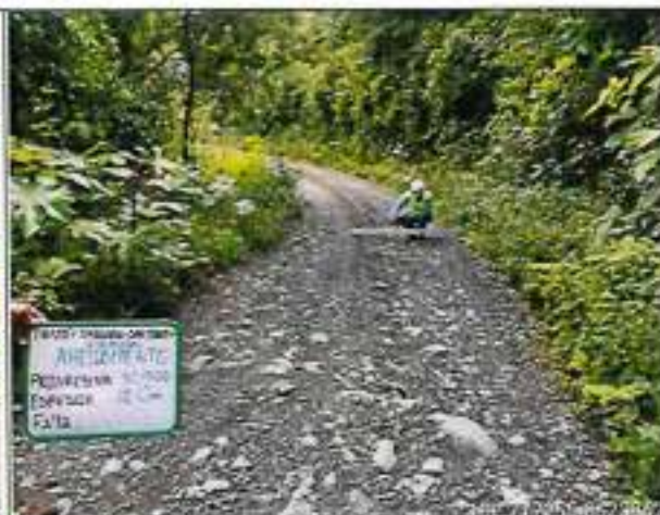
Foto 92: EROSION Y AHUELLAMIENTO km.80+800.
