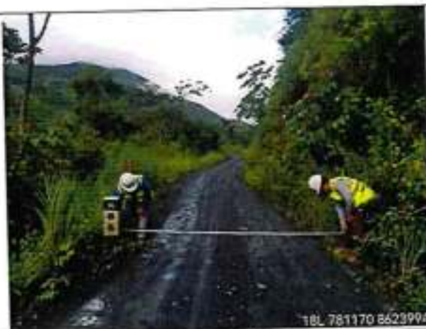
Foto N°01: CU-104_Medicion del ancho de la calzada.
