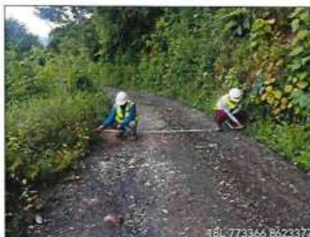
Foto 21: ANCHO DE PLATAFORMA 2.90m – km.74+820.
