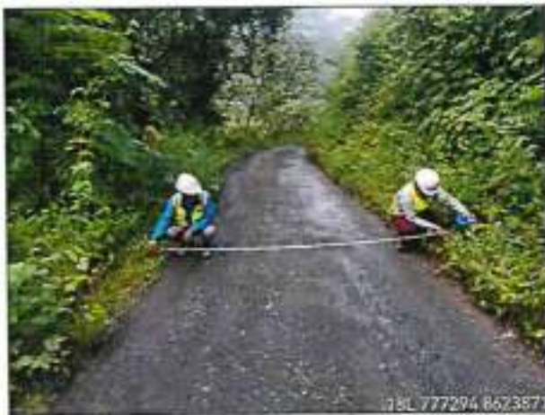
Foto 45: ANCHO DE PLATAFORMA 3.00m - km.80+840.
