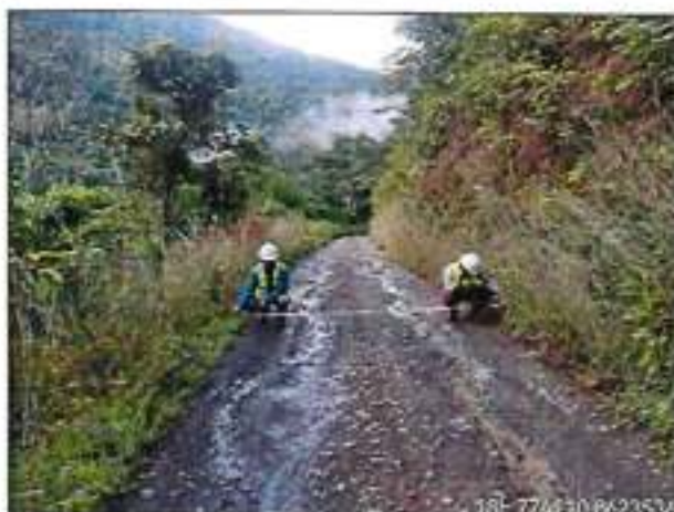
Foto 25: ANCHO DE PLATAFORMA 3.10m – km.75+900.
