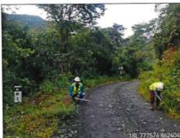
Foto 47: ANCHO DE PLATAFORMA 3.40m - km.81+340.
