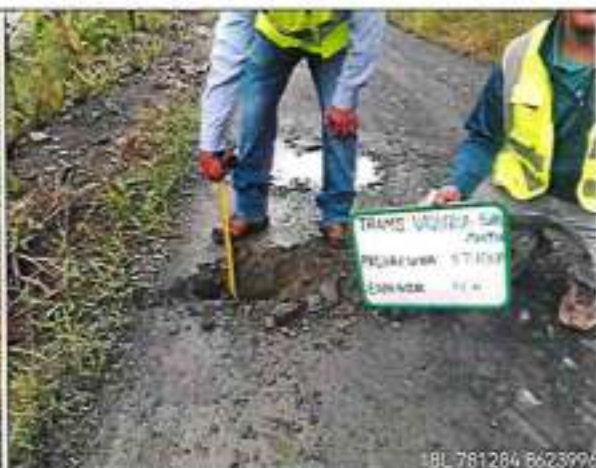
Foto 70: ESPESOR DE AFIRMADO EXISTENTE 7cm - km.86+500
