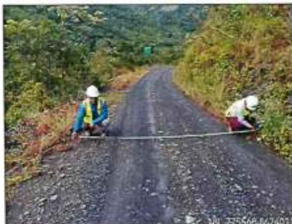
Foto 37: ANCHO DE PLATAFORMA 3.50m - km.78+745.
