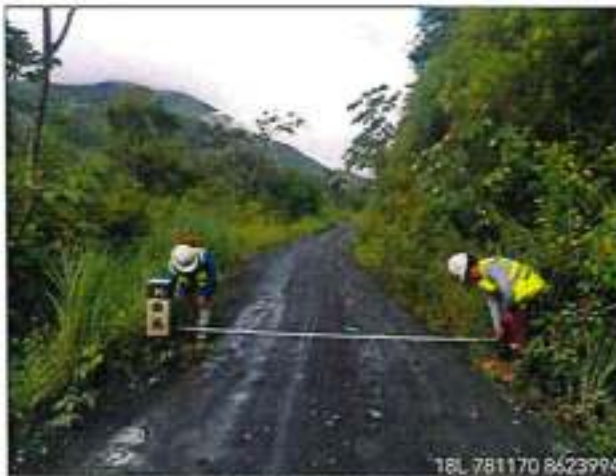
Foto 67: ANCHO DE PLATAFORMA 3.50m - km.86+340.
