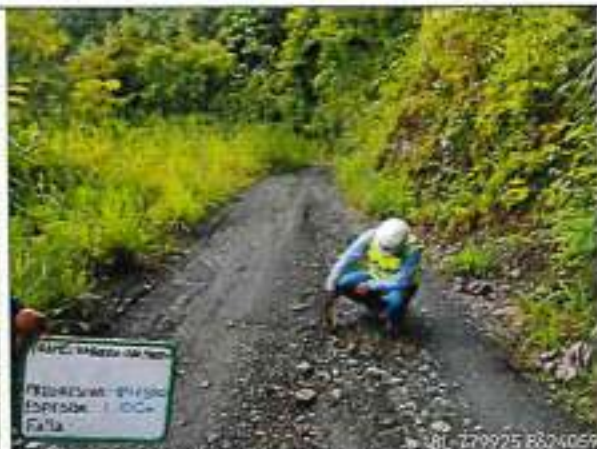
Foto 62: ESPESOR DE AFIRMADO EXISTENTE 10cm - km.84+780
