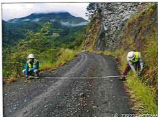
Foto 57: ANCHO DE PLATAFORMA 4.00m - km.83+820.
