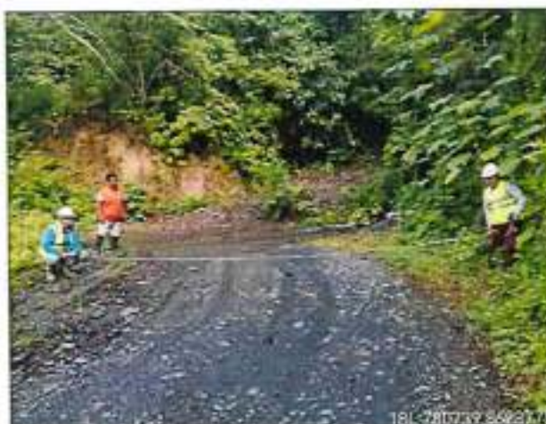
Foto 65: ANCHO DE PLATAFORMA 4.40m - km.85+830.
