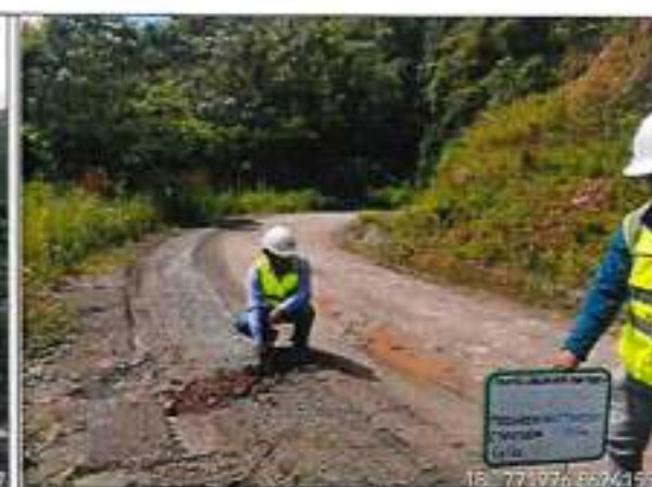
Foto 4: ESPESOR DE AFIRMADO EXISTENTE 10cm - km.70+100
