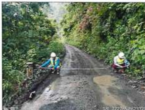
Foto 15: ANCHO DE PLATAFORMA 3.60m - km.73+390.
