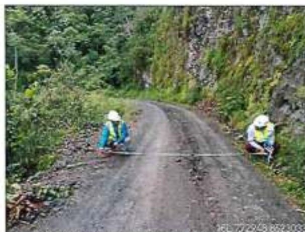
Foto 17: ANCHO DE PLATAFORMA 3.10m - km.73+800.
