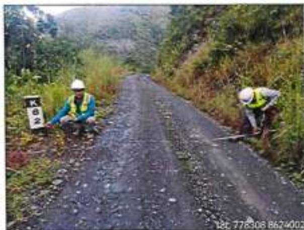
Foto 51: ANCHO DE PLATAFORMA 3.70m – km.82+340.
