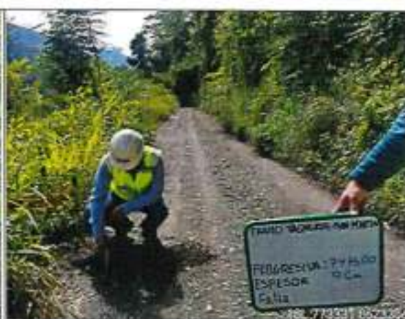
Foto 22: ESPESOR DE AFIRMADO EXISTENTE 9cm – km.74+790
