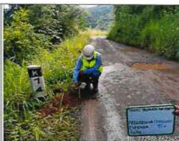
Foto 20: ESPESOR DE AFIRMADO EXISTENTE 9cm – km.74+390
