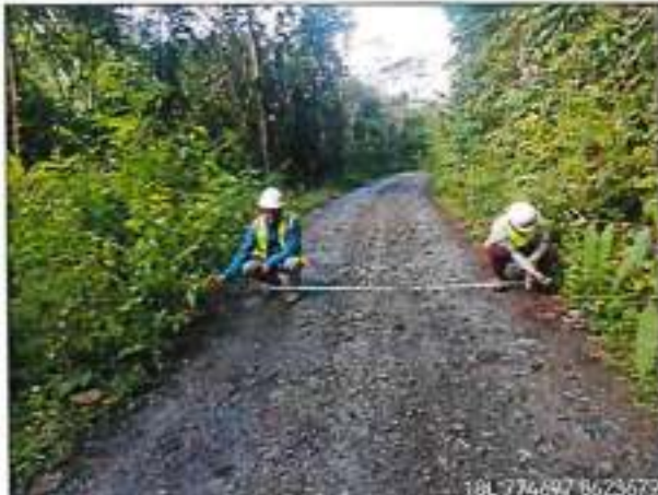
Foto 33: ANCHO DE PLATAFORMA 3.00m - km.77+710.
