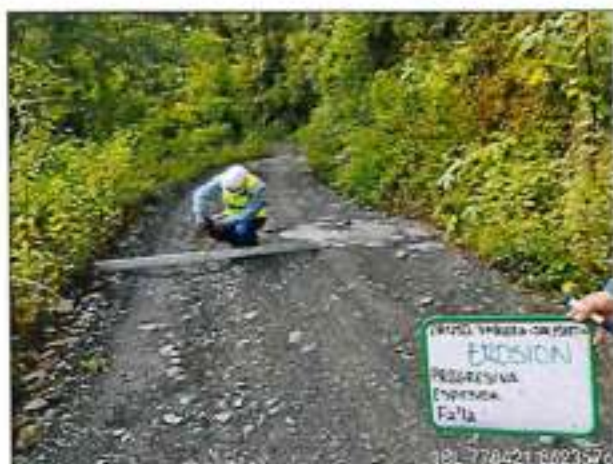
Foto 97: EROSION - AHUELLAMIENTO km.83+020.
