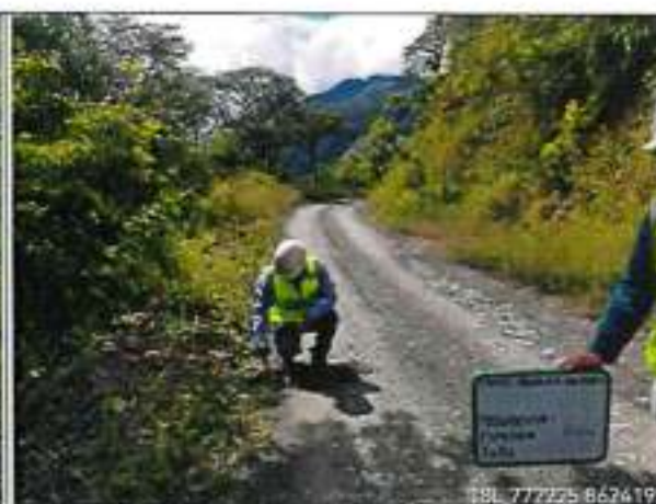
Foto 10: ESPESOR DE AFIRMADO EXISTENTE 10cm - km.71+810
