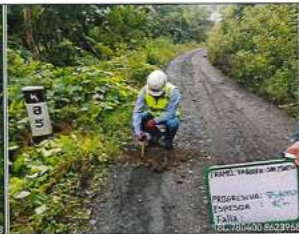
Foto 64: ESPESOR DE AFIRMADO EXISTENTE 8cm - km.85+340
