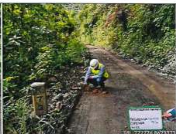
Foto 16: ESPESOR DE AFIRMADO EXISTENTE 9cm - km.73+390
