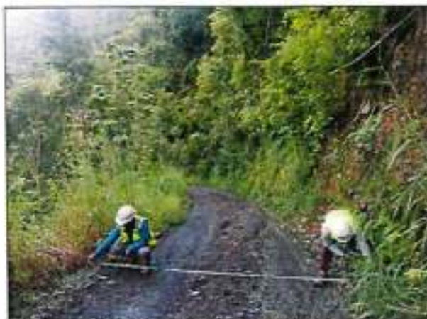
Foto 61: ANCHO DE PLATAFORMA 3.60m - km.84+800.
