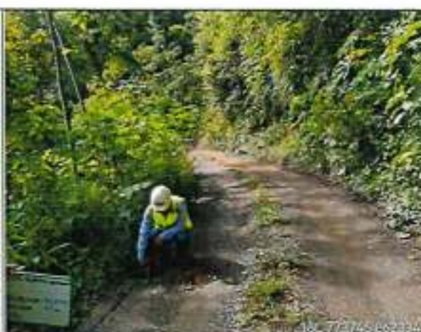
Foto 24: ESPESOR DE AFIRMADO EXISTENTE 9cm – km.75+320
