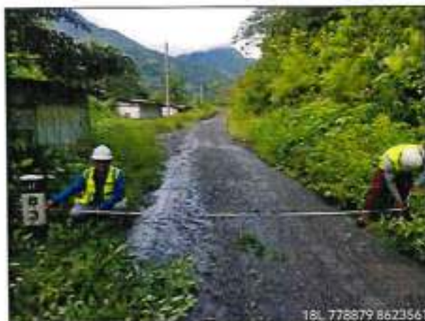
Foto 55: ANCHO DE PLATAFORMA 4.10m - km.83+340.
