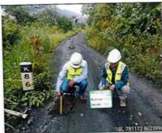
Foto N°02: CU-104_Espesor de afirmado existente.
