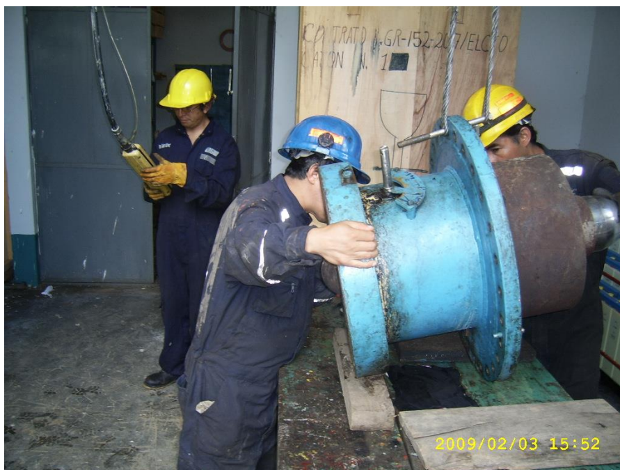
Fotografía 3: Maniobras de desmontaje de Actuador Hidráulico.
