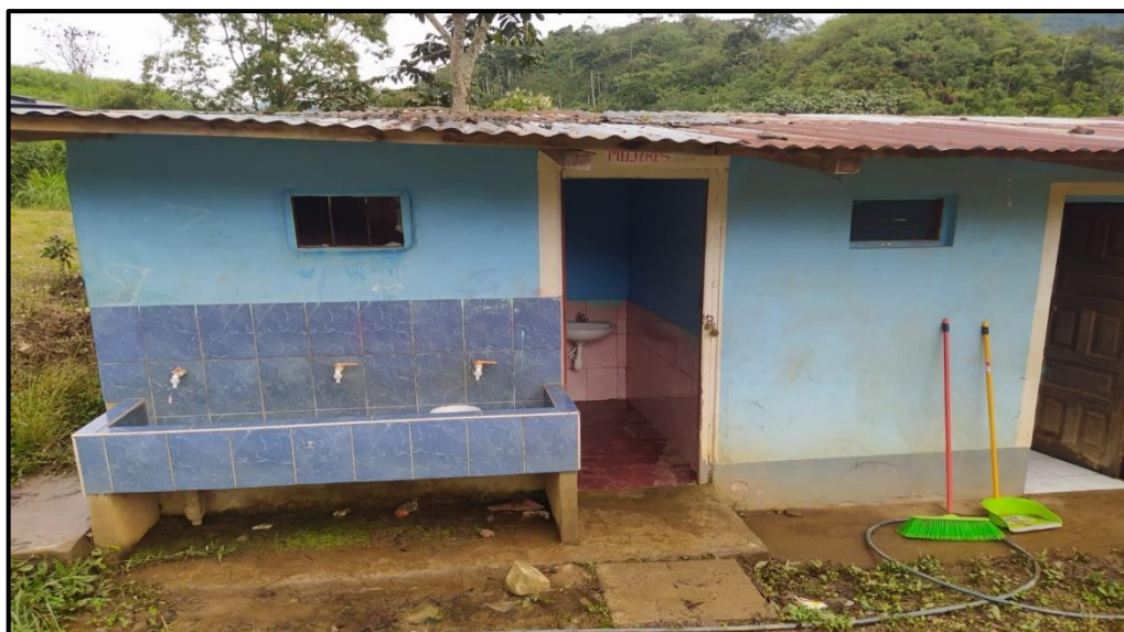
Foto N° 02: SS.HH. con techo de calamina en mal estado. Enchapados en mal estado. Accesorios y aparatos sanitarios incompletos y/o en mal estado
