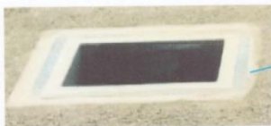
termofusión de material polylock con geomembrana en la caja de salida de tubería
