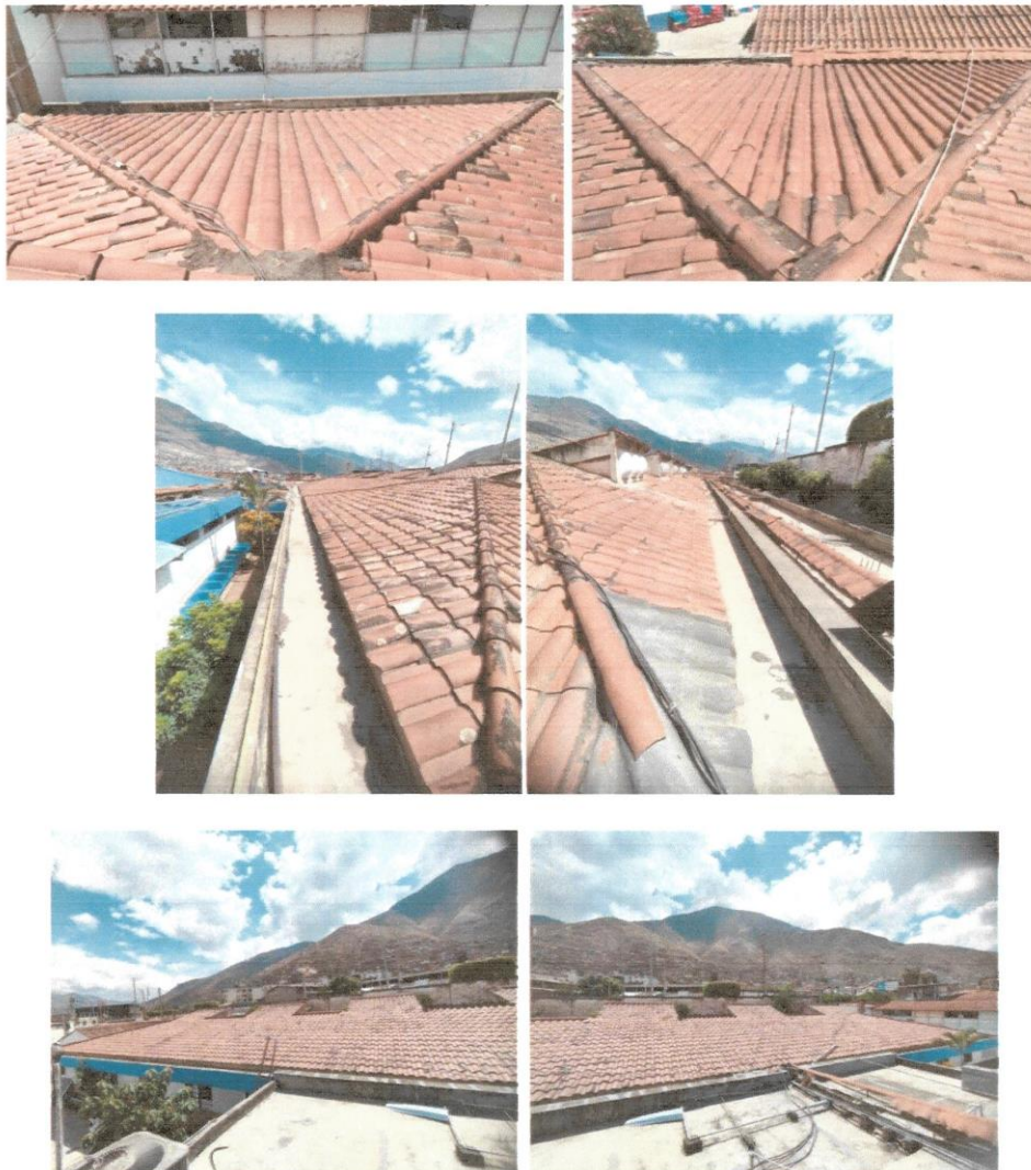
IMAGEN 5,6,7,8,9,10: Vista cobertura de teja andina en mal estado.
