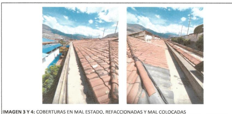
IMAGEN 3 Y 4: COBERTURAS EN MAL ESTADO, REFACCIONADAS Y MAL COLOCADAS
