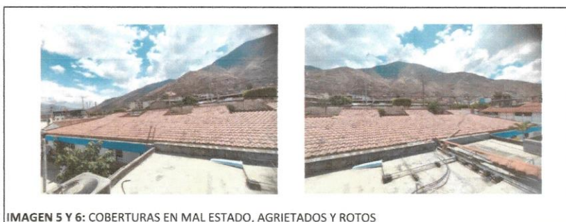
IMAGEN 5 Y 6: COBERTURAS EN MAL ESTADO, AGRIETADOS Y ROTOS
