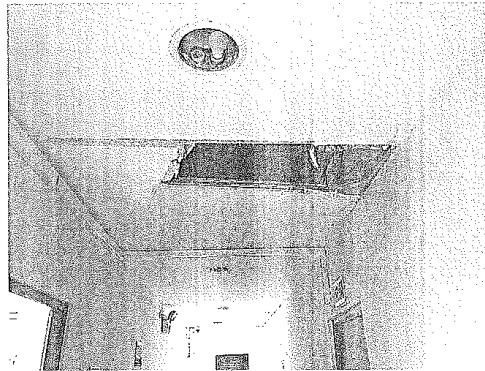
Foto N° 01: Se puede apreciar que parte del cielorraso de drywall se encuentra con forados producto de la filtración de agua de la cobertura liviana que sufrió daños tras las lluvias.
