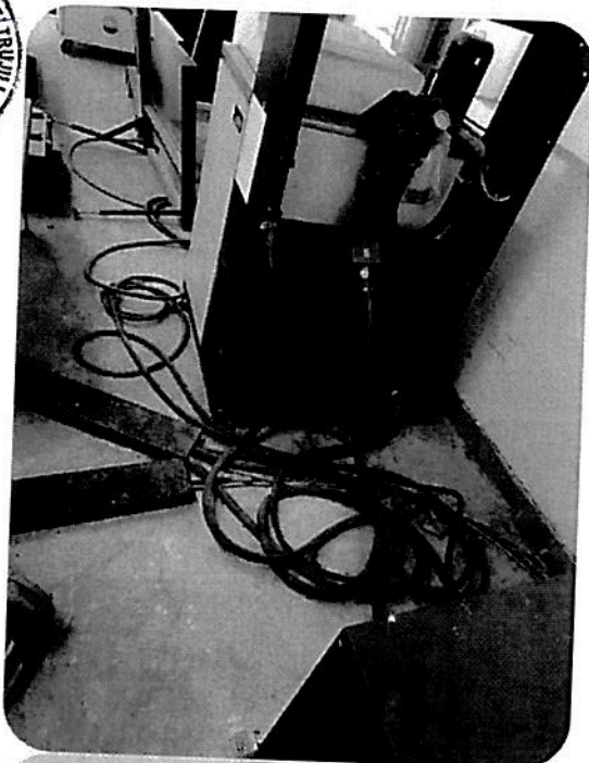
CABLES EXPUESTOS EN IMPRENTA
