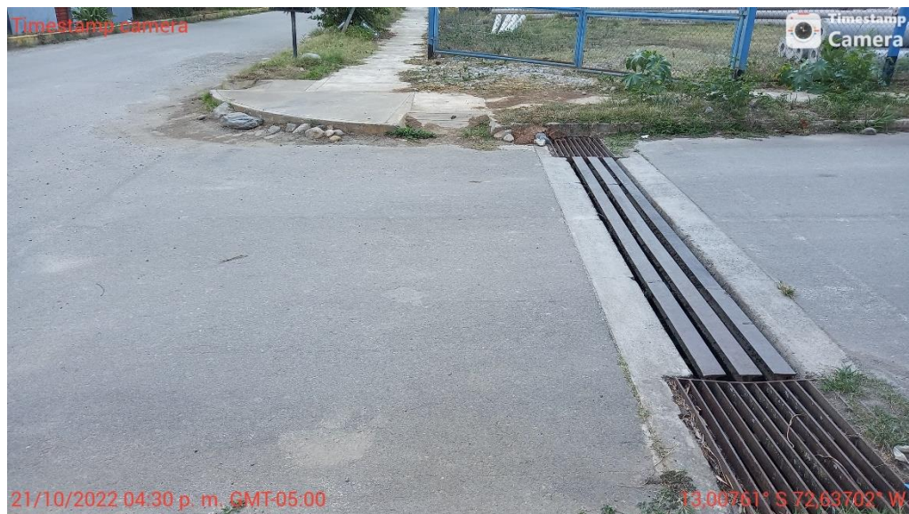
Figura 30: Canaleta en la vía de la calle este de la SE
