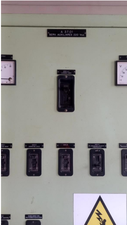
Figura 15: Tablero de SSAA, Interruptores
