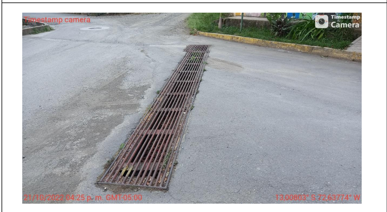
Figura 22: Canaleta en vía de la calle oeste de la SE.
