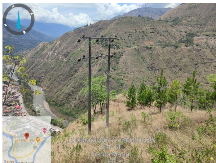
Figura 32: Biposte de madera ubicado cerca de la estructura 053
