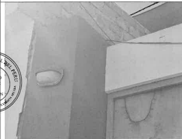
CAMBIO DE LUMINARIA APLIQUE EXTERIOR TORTUGA - IP65
