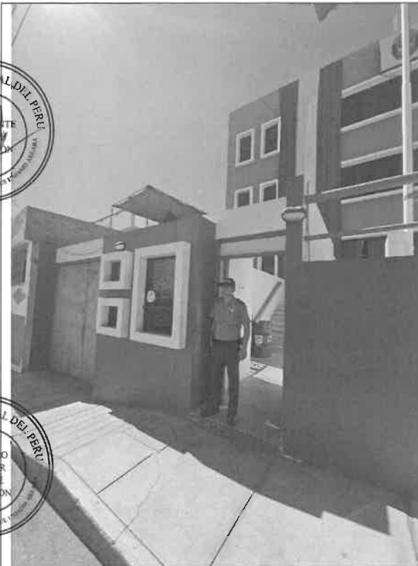
PINTURA LATEX 2 MANOS SATINADA EN MUROS EXTERIORES
