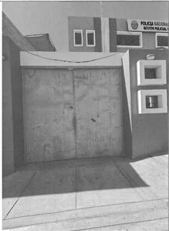
LIMPIEZA MECANICA, LIJADO, PINTADO DE PORTON METALICO
