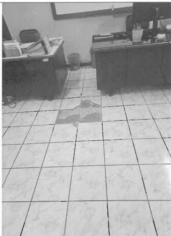
CAMBIO DE CERAMICO EN PISO 30x30cm IGUAL O SIMILAR AL EXISTENTE
