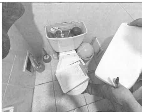
CAMBIO DE VALVULA C/PALANCA PARA INODORO
