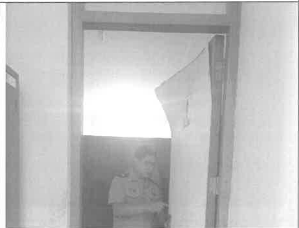
CAMBIO DE FORMICA BLANCA EN CARA DE PUERTA 0.83 x 2.10m
