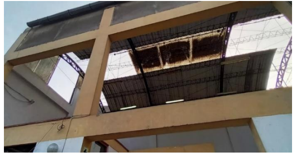
Foto N° 02: Se observa el mal estado del cerramiento lateral de la Planta de Residuos Sólidos. Zonas n sin cerramiento lateral.
