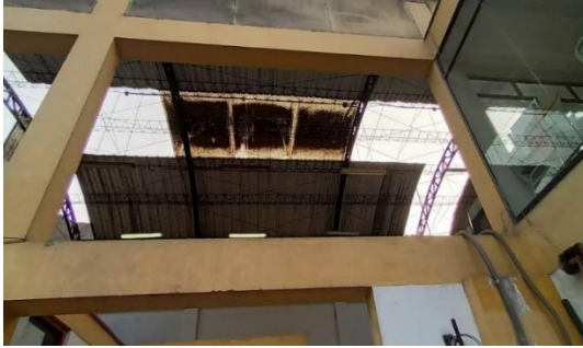
Foto N° 01: Se observa el mal estado de la cobertura de techo existente en Planta de Residuos Sólidos. Zonas sin cobertura de techo.
