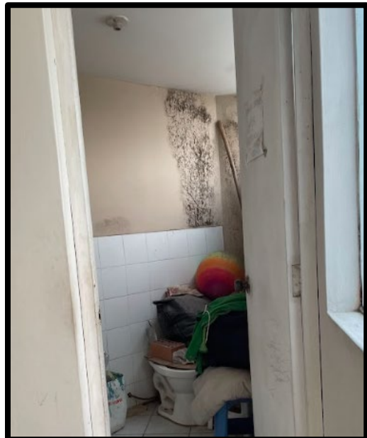
Fotografía N° 34: Vista de muros Interiores y cielo raso con presencia de humedad en SS.HH. de la zona de administración.
