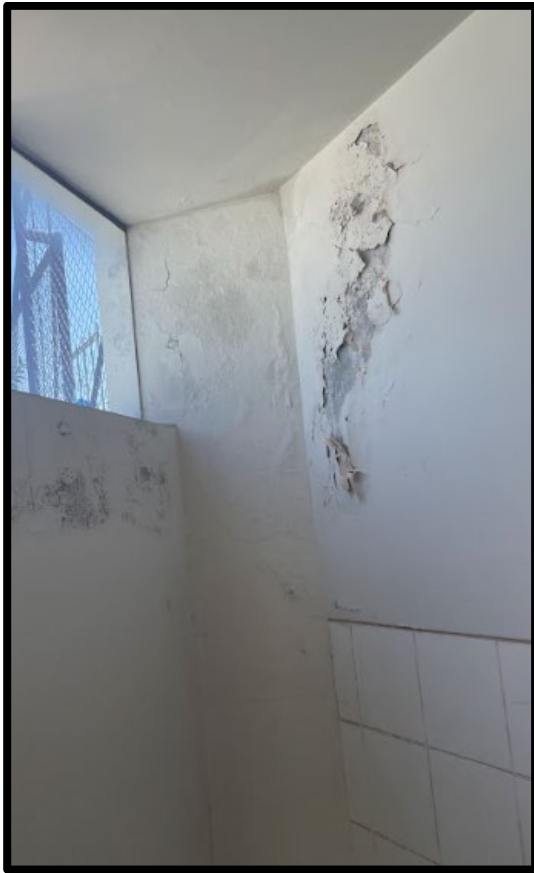
Figura N° 39: Vista de muros interiores con salitre en SS. HH. de oficina de seguridad.
