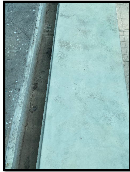
Fotografía N° 24: Vista de detalle de la canaleta cercana a la piscina, la misma que no se encuentra. La misma que se tiene que reponer.
