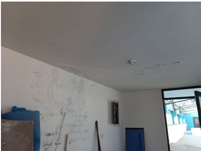
Figura N° 41: Vista de muros interiores y cielo raso con salitre en oficina de seguridad.
