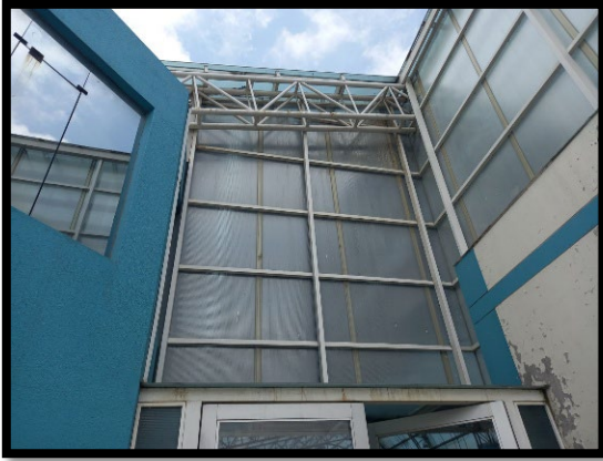
Fotografía N° 15: Vista del ingreso calle Buenos Aires se observa la estructura oxidada, y el policarbonato que se está malogrando.
