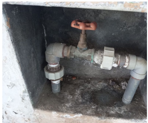
Figura N° 42: Vista de válvula de paso existente, la cual presenta filtraciones por los años de uso malas conexiones.
