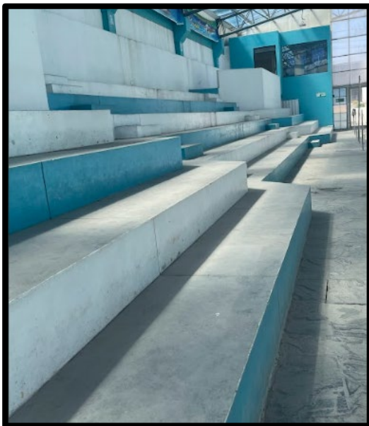
Figura N° 37: Vista de gradas para espectadores con pintura deteriorada, falta mantenimiento.
