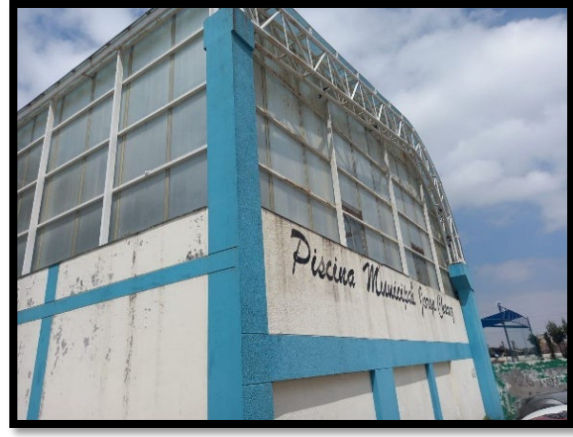
Fotografía N° 9: Vista en perspectiva de la fachada de la piscina se aprecia el mal estado de conservación y deterioro de la estructura metálica junto con los paneles de policarbonato, los mismos que se están oxidando por falta de mantenimiento.
