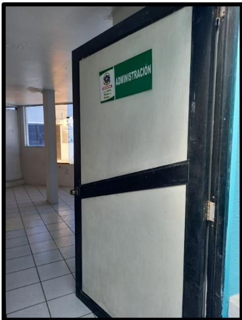
Figura N° 43: Vista de puerta metálica que necesita mantenimiento anticorrosivo, pintura a dos manos y colocación de vidrios en oficina de administración.
