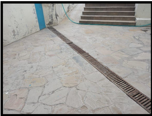
Fotografía N° 14: Vista del piso de laja del ingreso por la calle Buenos Aires, observa la canaleta oxidada, y el piso falta de mantenimiento.
