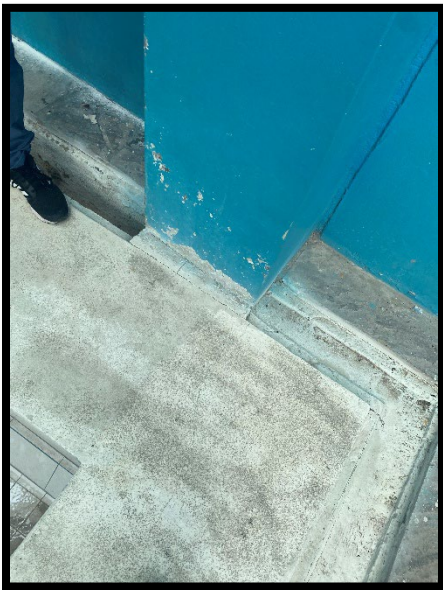
Fotografía N° 25: Vista de la falta de canaleta alrededor de la piscina.
