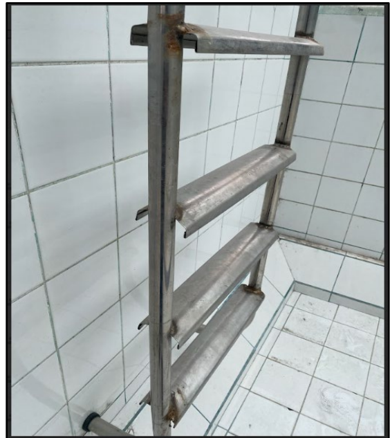
Fotografía N° 32: Vista de detalle de la estructura de la escalera a piscina, oxidado.
