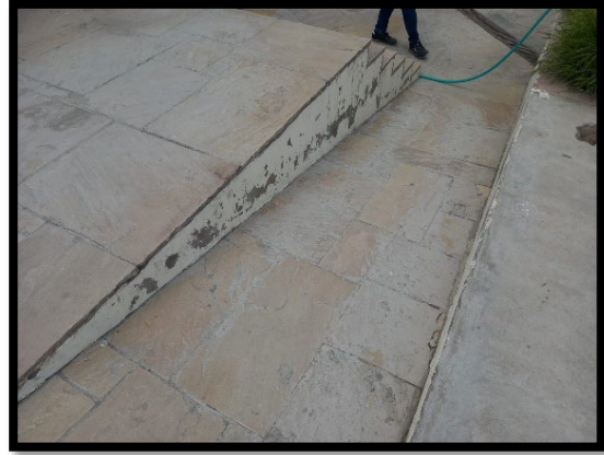
Fotografía N° 16: Vista del acceso para discapacitados falta de mantenimiento.
