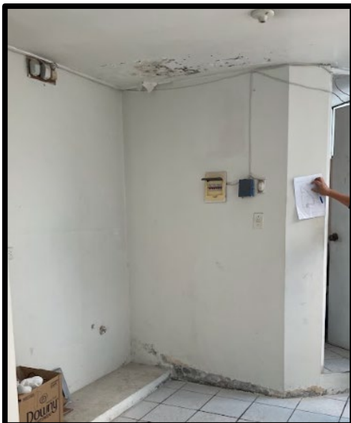
Fotografía N°33: Vista de muros Interiores y cielo raso con presencia de humedad en la zona de administración.
