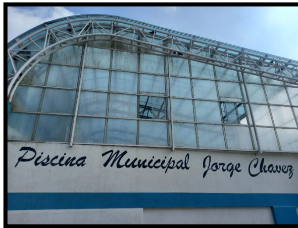
Foto N° 3: Se observa la parte alta de la fachada y la Estructura deteriorándose por falta de mantenimiento
