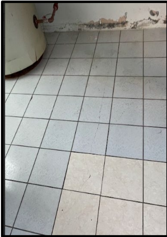
Figura N°35: Vista de piso cerámico con presencia de grietas y ciertas áreas con distintas características a de administración.
