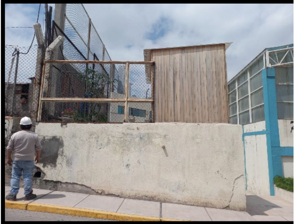
Fotografía N° 12: Vista frontal parte de la fachada, véase el cerco metálico y la caseta de madera en mal estado de conservación por la falta de mantenimiento.
