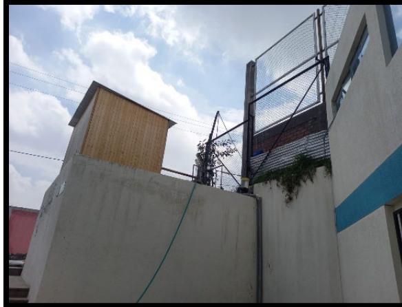
Fotografía N° 13: Vista del mismo lugar por la parte de atrás se aprecia el deterioro de la reja, que se está oxidando.
