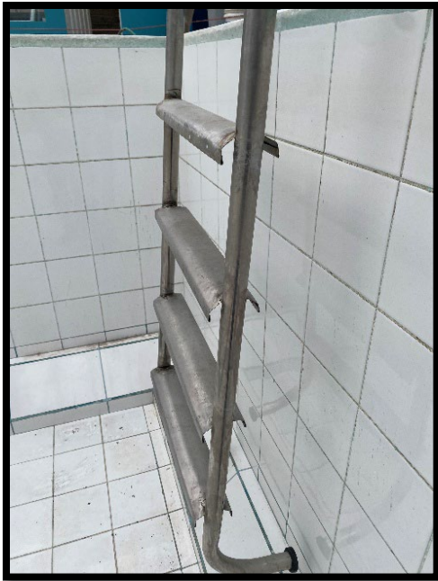
Fotografía N° 19: Vista de la escalera de la piscina véase la falta de mantenimiento la misma que se está oxidando.
