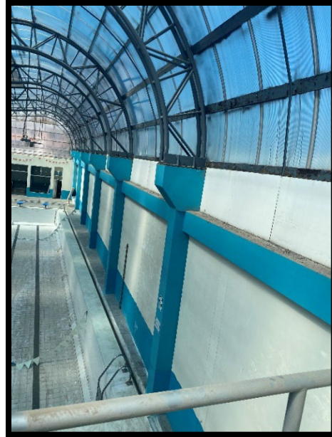
Fotografía N° 28: Vista de detalle de la estructura de la cobertura de la piscina, falta de mantenimiento y limpieza.
