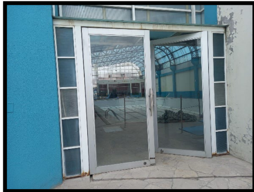
Fotografía N° 15: Vista de la puerta de ingreso calle Buenos Aires se ve la estructura de la puerta que se está oxidando, así como la pintura se viene descascarando.
