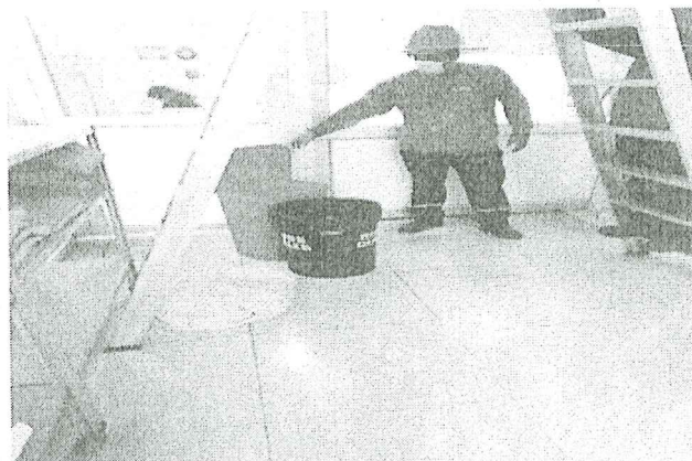
Foto 04: El agua se empoza en los pisos de hospitalización, el cual es generado por los goteos de agua empozada en el techo.
