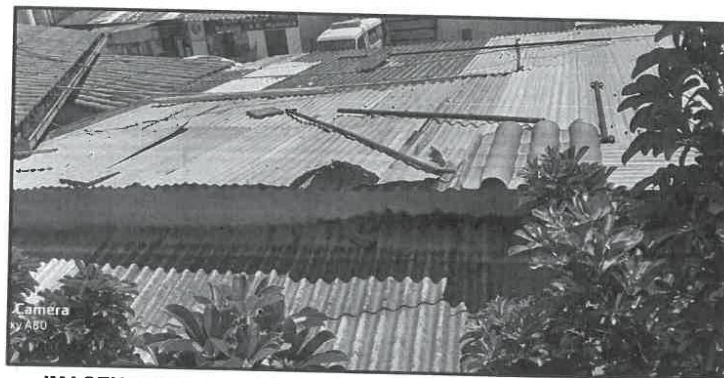
IMAGEN 2: Cobertura deteriorada del área de Servicios Generales
