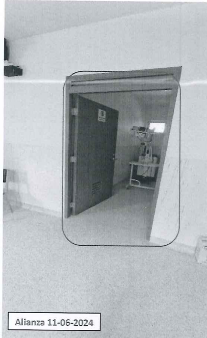
FOTO 23.- DESMONTAJE DE PUERTA Y SELLADO DE MURO DE LADRILLO EN AMBIENTE DE PUERPERIO
