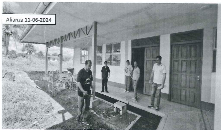
FOTO 24.- AMPLIACIÓN DE VEREDA CON FALSO PISO DE CONCRETO A NIVEL DE CUNETETA, ADEMÁS DE LA NIVELACIÓN DE UNA CAJA DE REGISTRO
