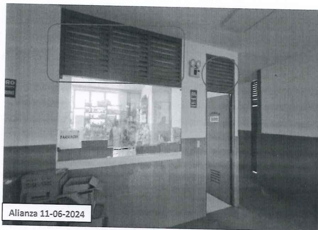
FOTO 28.- SELLADO DE VENTANA CON VIDRIO TEMPLADO EN AMBIENTE DE FARMACIA
