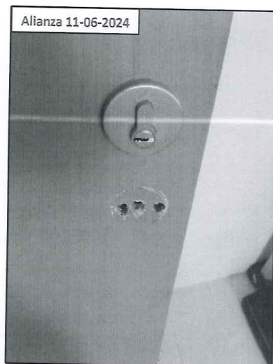
FOTO 15.- CERRADURAS EN MAL ESTADO
