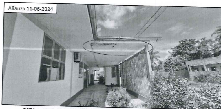
FOTO 4.- CIELO RASO PRESENTA DESPRENDIMIENTO DE CINTAS TAPA JUNTAS
