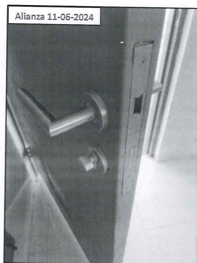
FOTO 16.- CERRADURA CON EL PIN MALOGRADO.
