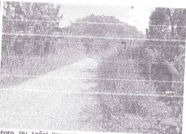
Foto 26: Señal Preventiva, progresiva 75+912, en buen estado de conservación, con superficie de rodadura con afirmado y estado de transitabilidad regular.
