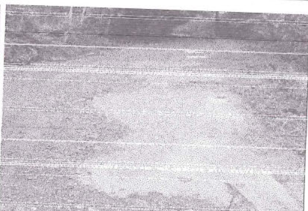
Foto 76: Superficie de rodadura Tramo 1+286 - 1+500, con superficie de rodadura con afirmado y estado de transitabilidad regular.
