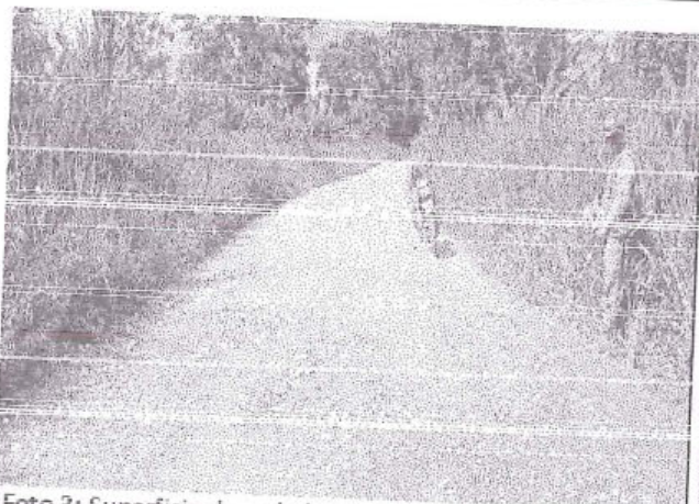
Foto 3: Superficie de rodadura Tramo 70+346 - 70+500, con superficie de rodadura con afirmado y estado de transitabilidad bueno.
