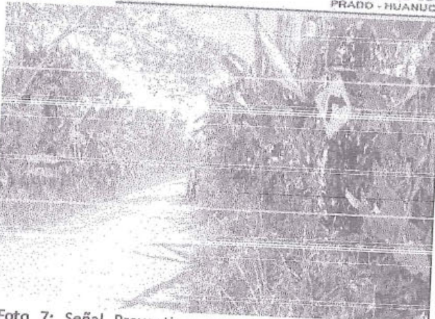
Foto 7: Señal Preventiva, progresiva 71+868, en buen estado de conservación, con superficie de rodadura con afirmado y estado de transitabilidad bueno.
