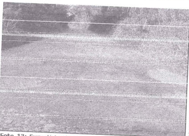
Foto 13: Superficie de rodadura Tramo 73+254 - 73+500, con superficie de rodadura con afirmado y estado de transitabilidad regular.
