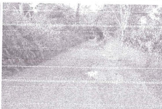
Foto 115: Baches de nivel de gravedad 2, presente en el tramo 73+706 al 73+723, con superficie de rodadura de afirmado y estado de transitabilidad bueno.
