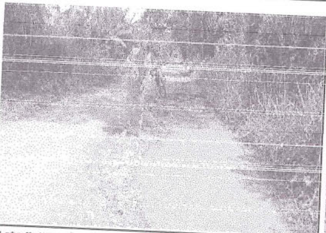
Foto 9: Superficie de rodadura Tramo 72+000 - 72+500, con superficie de rodadura con afirmado y estado de transitabilidad regular.
