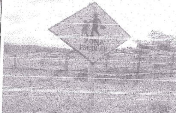
Foto 92: Señal Informativa, progresiva 2+701, en buen estado de conservación, con superficie de rodadura con afirmado y estado de transitabilidad regular.
