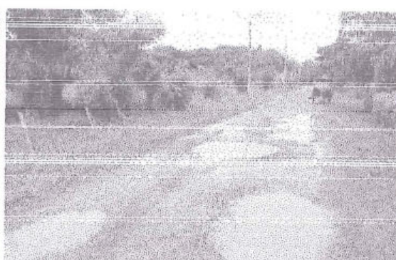
Foto 149: Baches de nivel de gravedad 2, presente en el tramo 0+276 al 0+364, con superficie de rodadura de afirmado y estado de transitabilidad bueno.
