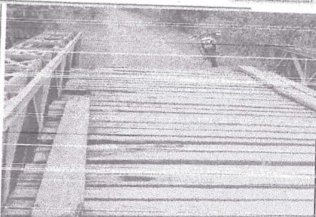
Foto 38: Puente Modular, vista tablero de rodadura, progresiva 77+591, estado de transitabilidad regular.
