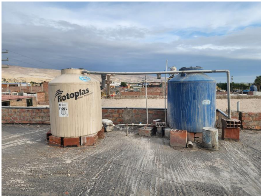
F9: Suministro e instalación de 02 tanques de agua incluido accesorios, suministro e instalación de 02 bases de estructura metálica para cada tanque.
