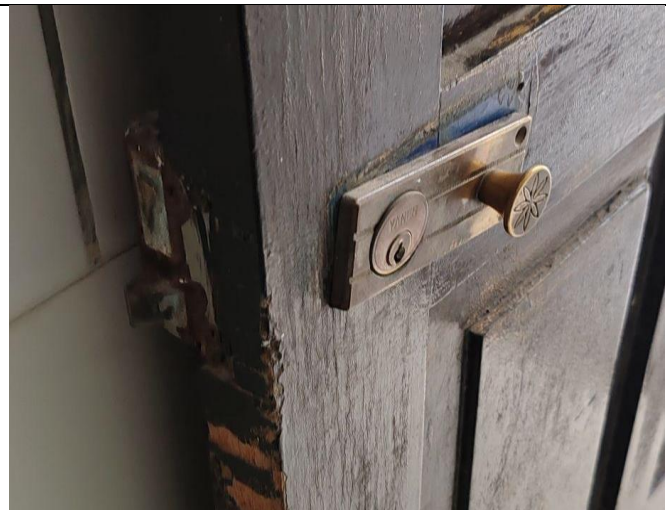
F5: Reposicion de cerrojos en mal estado
