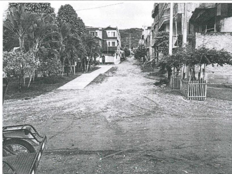
IMAGEN 10 - CALLE LOS ROMERILLOS CUADRA 01 SUPERFICIE DE RODADURA EN PESIMAS CONDICIONES DE TRANSITABILIDAD, PRESENCIA DE CHARCOS Y LODOS DEBIDO A LA FALTA DE DRAJAJE PLUVIAL, SE OBSERVA LA PRESENCIA DE POSTES DE ALUMBRADO PÚBLICO.
