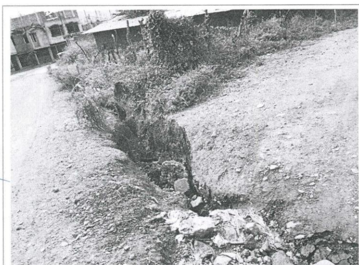
IMAGEN 25 – INTERSECCIÓN DE LA CALLE SAN JOSÉ Y CALLE 25 DE OCTUBRE CUADRA 04, EROSION DEL SUELO PROCEDENTE DE LAS ESCORRENTIA DE LAS AGUAS DE LAS FUERTES PRECIPITACIONES, SUPERFICIE DE RODADURA EN PESIMAS CONDICIONES DE TRANSITABILIDAD.
