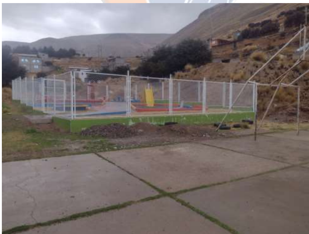
Imagen 5: En esta vista, se aprecia el deterioro de la losa con fisuras y sin mantenimiento.
