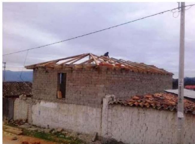
Las viviendas y edificaciones turísticas existentes presentan tijerales de eucalipto que son colocados como estructura de soporte en la cobertura
