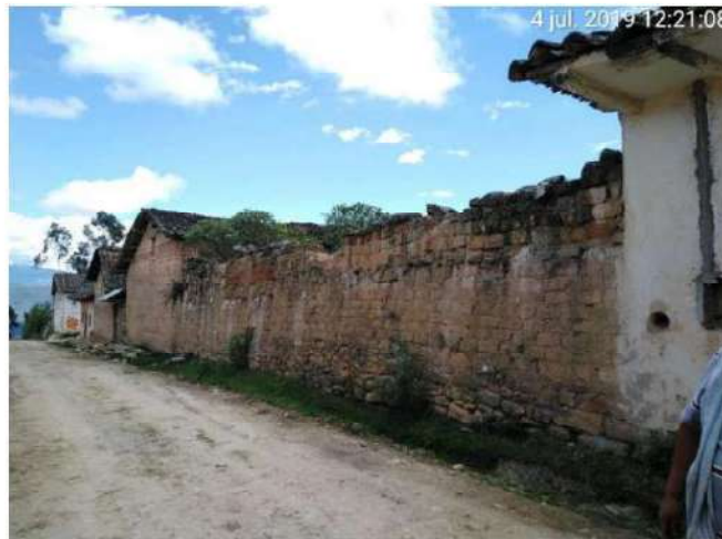
Variedad de muros, algunos son de piedra y la mayoría de ellos de adobe. Este muro colorido es de adobes hechos con tierra y arcilla en tonos amarillos, cremas y naranjas
