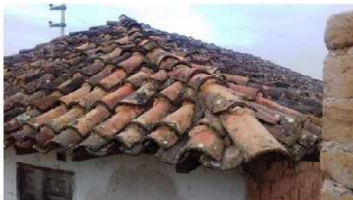
Tejado tradicional, encuentro de un techo a dos aguas, las tejas se colocan en la cumbre para evitar el filtrado del agua y detalle de la cobertura, en algunos casos las tejas están deterioradas por el tiempo, la humedad y sus constantes lluvias.
